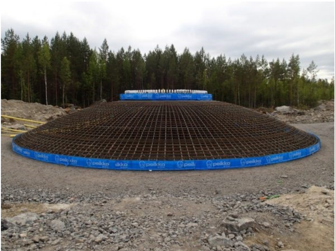
Kuva 8. Teräsbetoniperustus ennen valamista [37].
