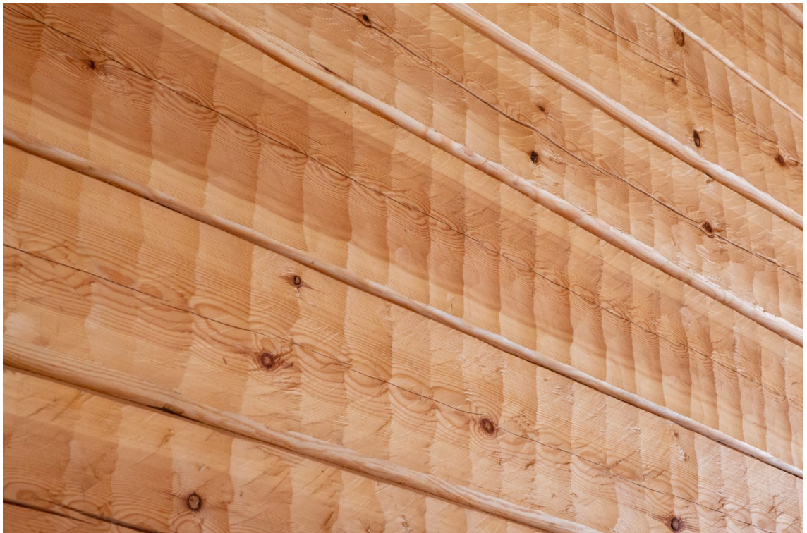
Kuva 20. Piiluttu hirsiseinä (Hirsityö Heikkilä 2020)
