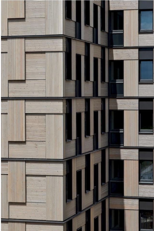
Kuva 7. Opiskelija-asuntola Woodien julkisivu. (Göts Wrage)
