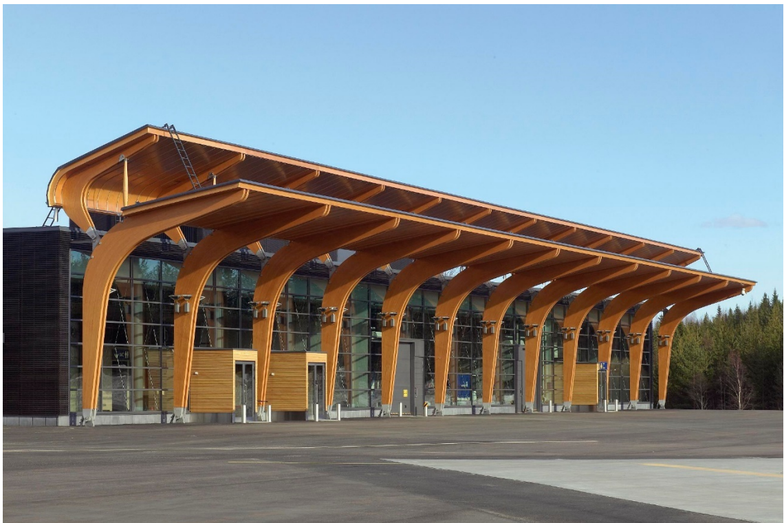
Kuva 21. Jyväskylän lentoaseman matkustajaterminaalien laajennus (Puuinfo 2020)
