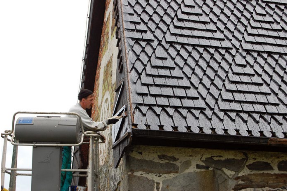
Kuva 10. Tyrvään Pyhän Olavin kirkon paanukaton tervaus. (Sastamalan seurakunta 2008)
