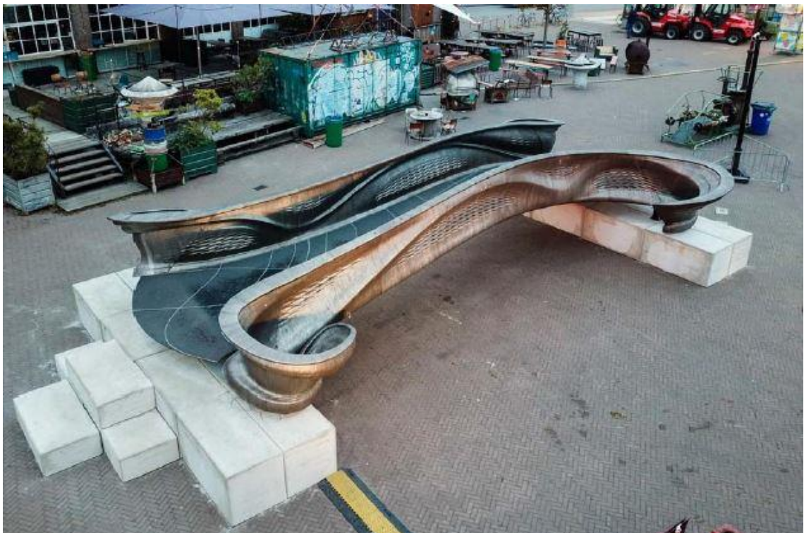
Kuva 11. MX3D-silta esillä Dutch Design Week -tapahtumassa vuonna 2018 (Buchanan & Gardner 2019, s. 10)
