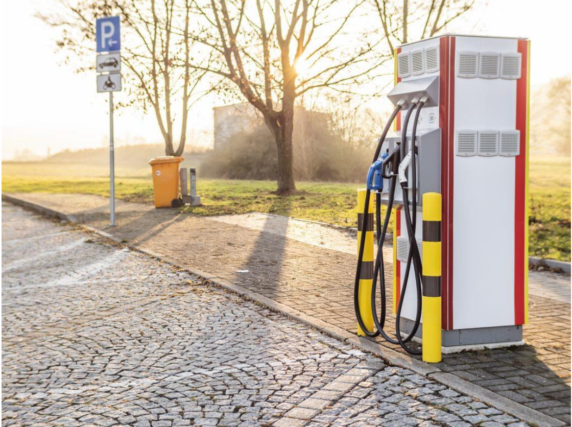
Kuva 19. Lataustavan 4 mukainen tasasähköllä toimiva teholatausasema [40].
