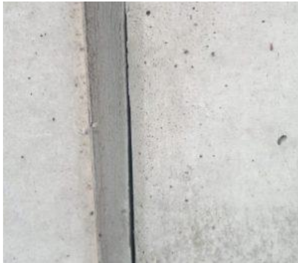
Kuva 7. Haitta-aineita tartuntapinnoilla (Panschin & Panschin 2021, s. 38)
