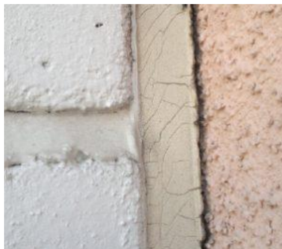
Kuva 2. Pettänyt tartunta rapatulle pinnalle (Panschin & Panschin 2021, s. 39)
