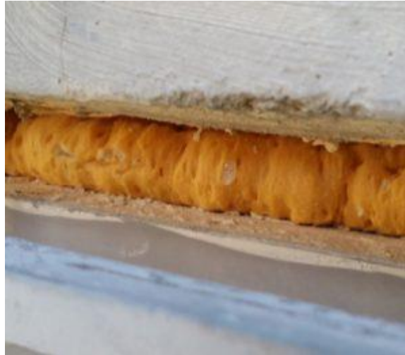
Kuva 8. Taustatilan tuuletus on tukittu (Panschin & Panschin 2021, s. 38)
