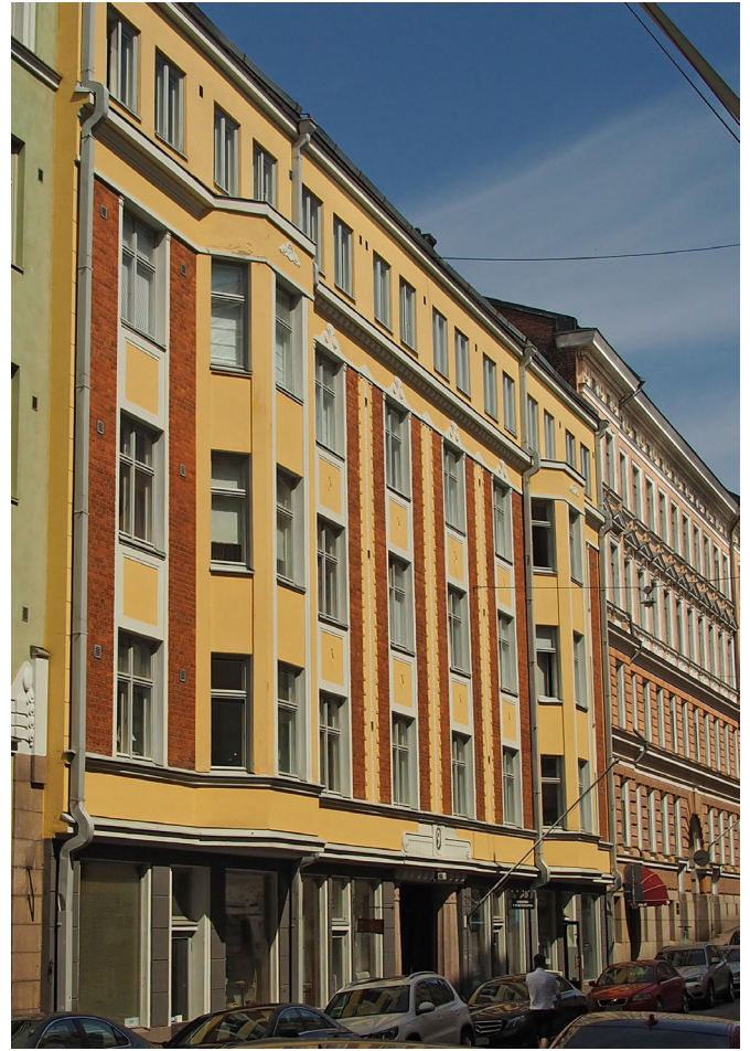
81. Ole Gripenberg korotti Vironkatu 9:ää vähäeleisesti mutta ajanmukaisesti 1936. Kuva 2020.
