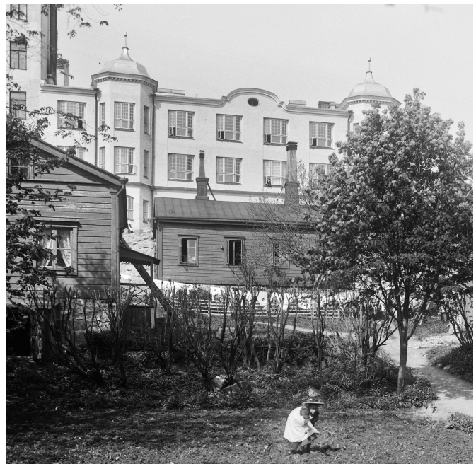
64. Meritullinkatu 15:n takajulkisivu näkyi korttelin läpi merelle. Signe Brander 1907, HKM/Finna CC BY 4.0, rajattu.
