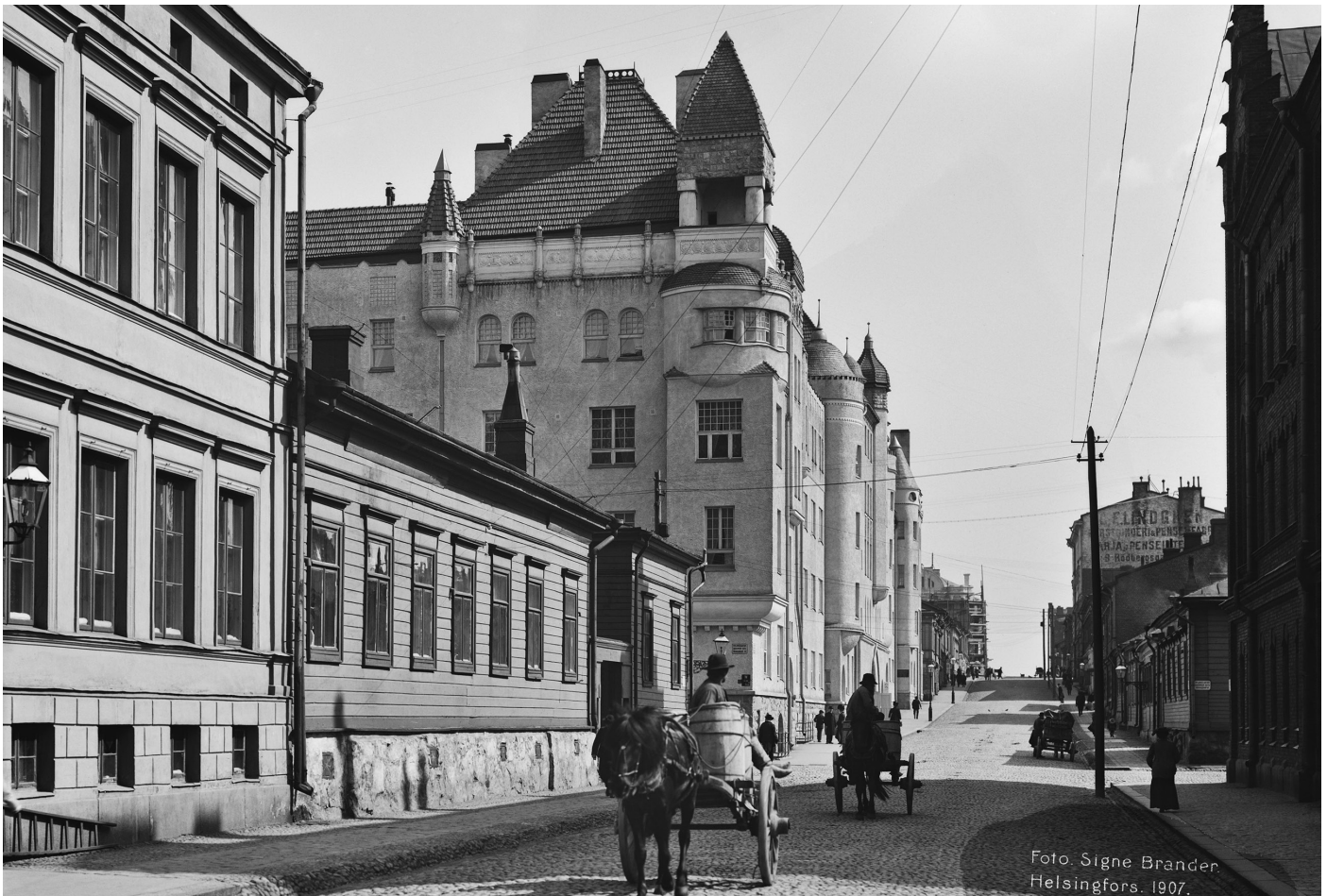
22. Vastavalmistunut Albertinkatu 19 (1907). Signe Brander 1907, HKM/Finna CC BY 4.0, rajattu.
