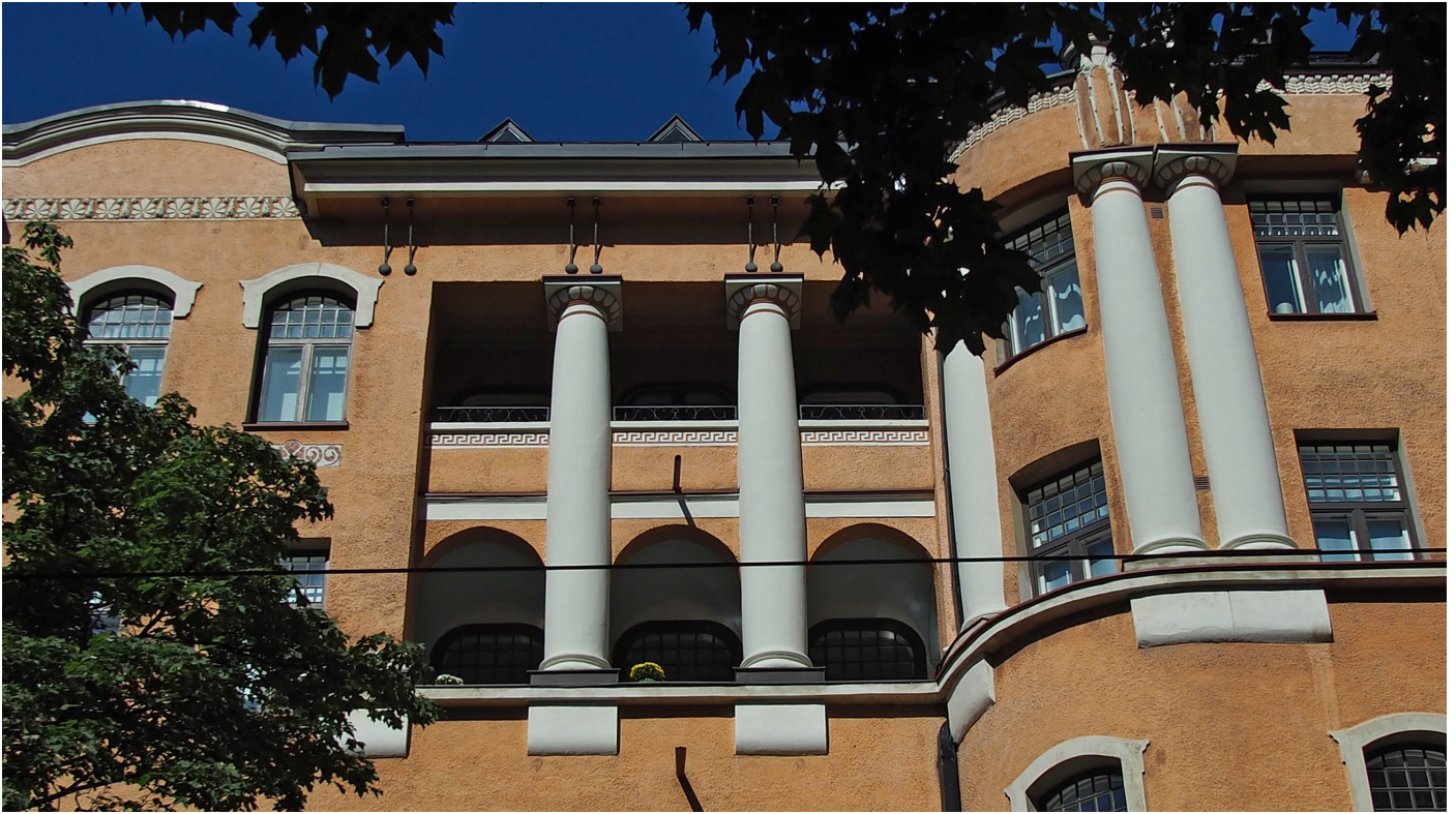
33. Bulevardi 19:n loggian pilaristo ja meanderilista. Kuva 2020.
