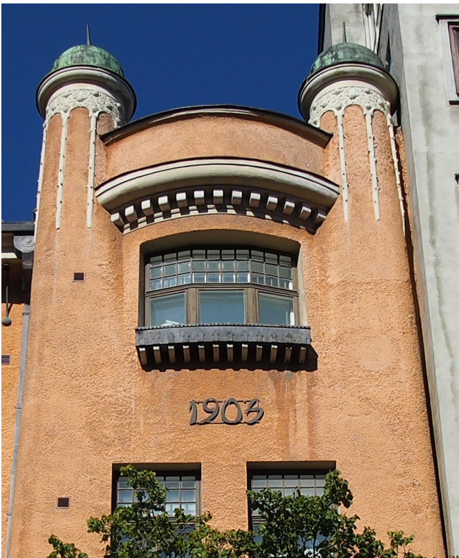
34. Bulevardi 17:n räystäsdetaljiikkaa. Kuva 2020.
