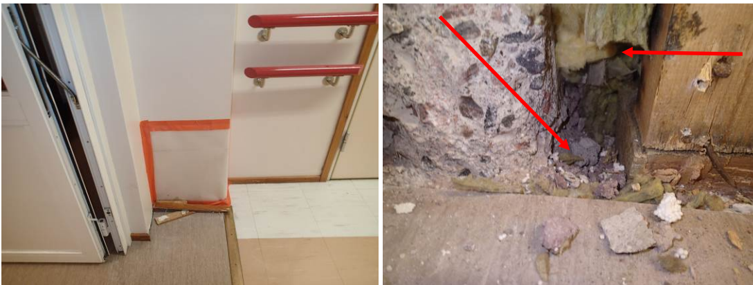
Kuvat 3 ja 4. Entinen ulkoseinä on muuttunut laajennuksen yhteydessä väliseinäksi. Seinän rakenteet ovat ennallaan. Valesokkelin eristetilasta tai sokkelihalkaisun eristetilasta (nuolet) todettiin ilmavuotoa huonetilaan päin.
