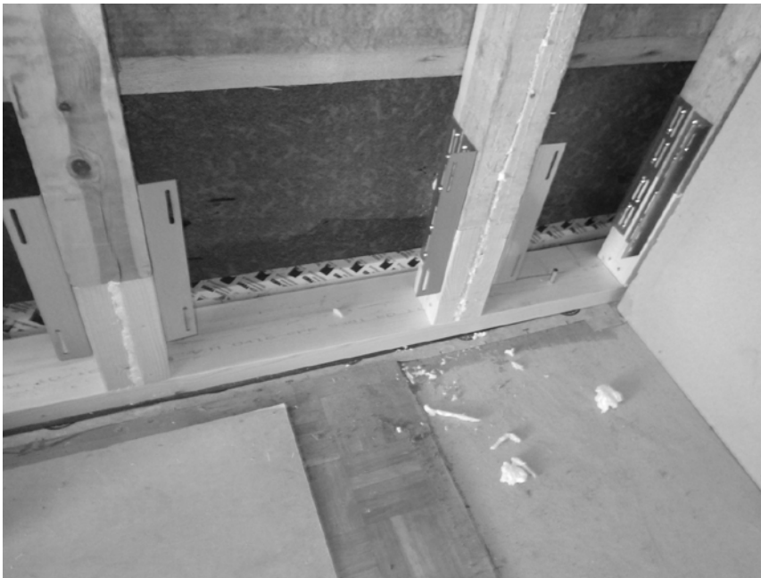
Kuva 6. Valesokkelikorjaus runkoon asti tehtynä.
