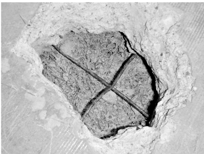
Kuva 3. Toja-levy eristeenä lattian alla.
