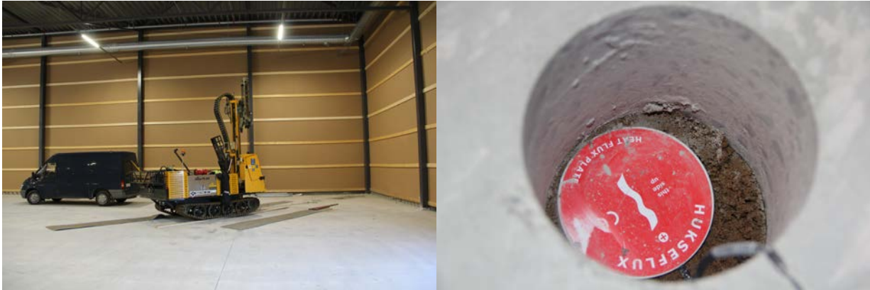
Kuva 3. Lämpötilojen mittausputkien asennuksessa käytetty porauslaite (vasemmalla) ja betonilaatan alle asetettu lämpövirtalevy (oikealla).
