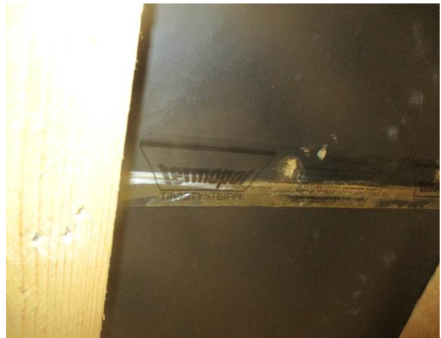
Kuva 4. Yläpohjan rakennetyyppi. Termopol -höyrynsulkulevyjen liitosten teippaukset ja liittymät ulkoseinä- ja yläpohjarakenteisiin ovat epätiivisiä.
