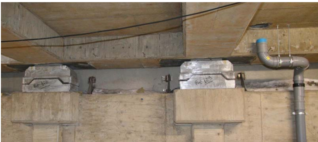
Kuva 6. Teräsjousiin perustuvat eristinelementit asennettuna autohallin pilareiden yläpäihin. Taustalla maanpaineiseinä, joka ei tukeudu yläpuoleiseen eristettyyn rakennuksen osaan. Kuvan oikeassa reunassa näkyvässä viemäriinjassa on joustoliitin, jolla estetään äänisilta eristyksen rajalla.
