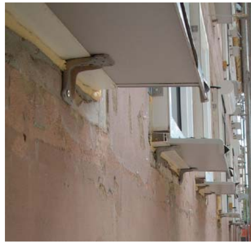
Kuva 1. Ingolstädter Straße 139/141. a) Yleiskuva 3 kerroksisesta, 1951 rakennetusta ja 2004 saneeratusta asuinkerrostalosta Nürnbergissä. b) Uusien ikkunoiden asennusdetalji. [2]
