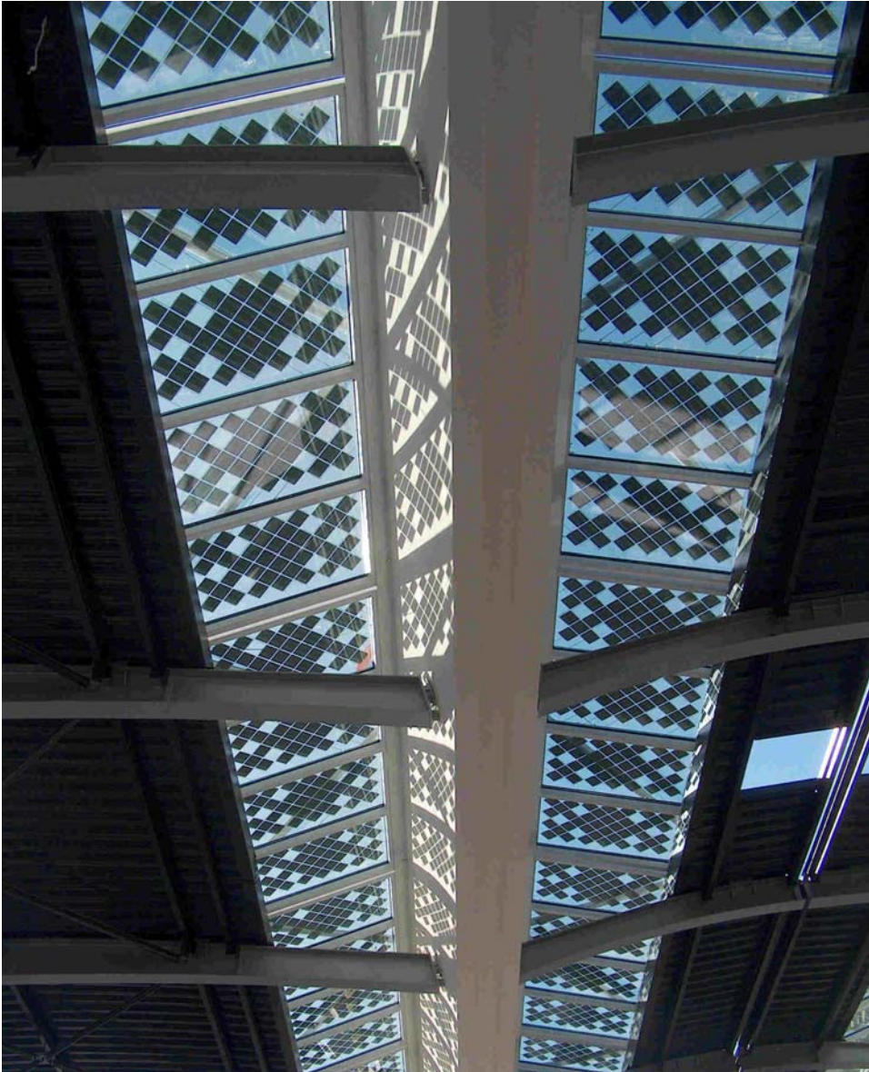
Kuva 5. Yksityiskohta, Naps Systemsin kattoikkunaelementit Casablancan lentoasemalla Marokossa. Huomaa paikalliseen makuun sopiva sommittelu.
