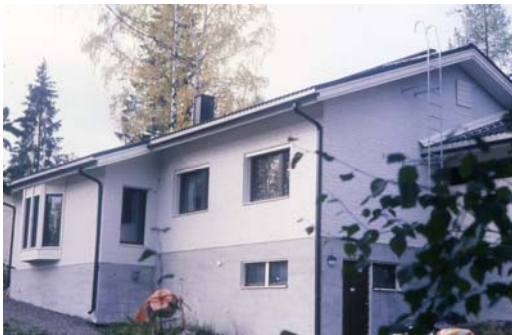
Kuva 1. Espooseen 1991 rakennetun matalaenergiapientalon ulkoseinä on puurakenteinen. Seinä koostuu naulalevyillä sidotuista 45 \times 70 \text{ mm} runkorakenteesta. Seinän eristyspaksuus on 300 \text{ mm} .
