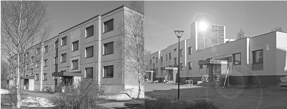
Kuva 1. Rakennus ennen purkamista.
