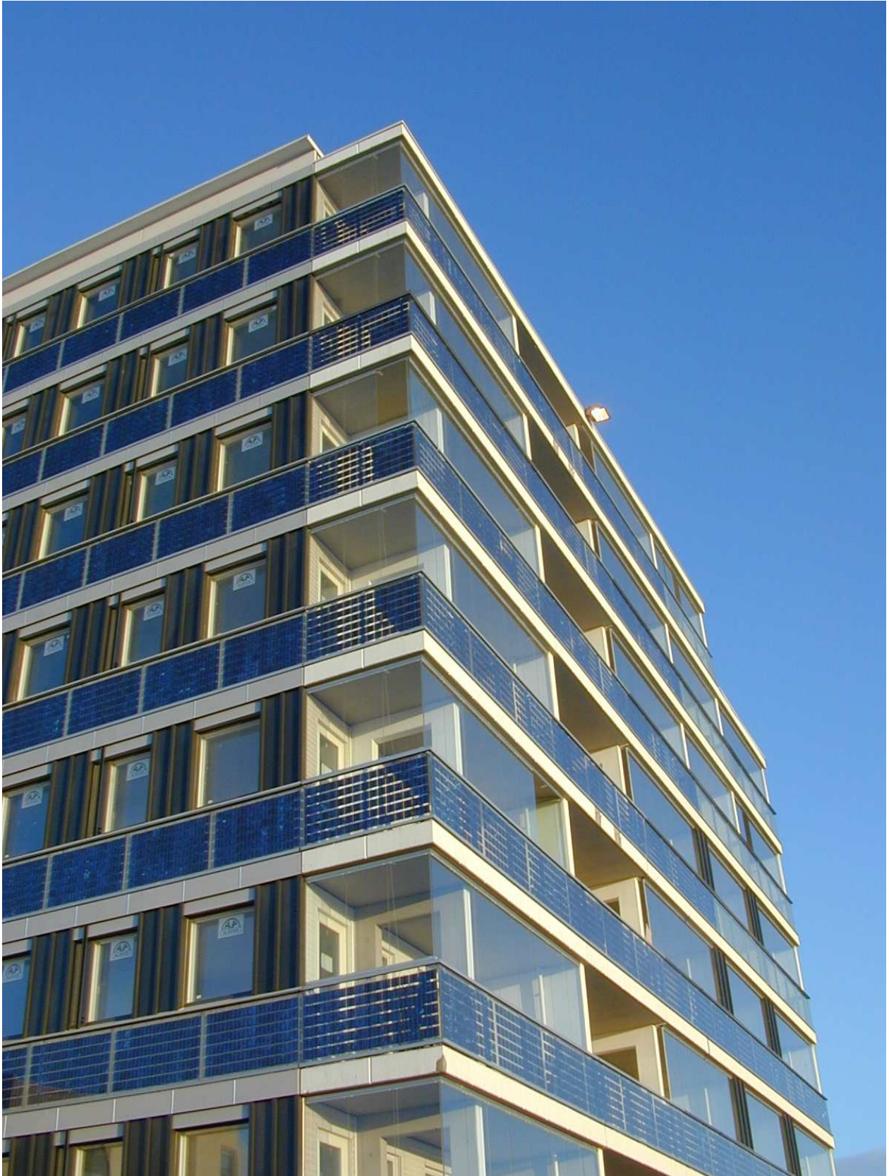
Kuva 3. Naps Systemsin seinä- ja parveke-elementteihin integroitu aurinkosähköjärjestelmä asuinkerrostalossa Viikissä.
