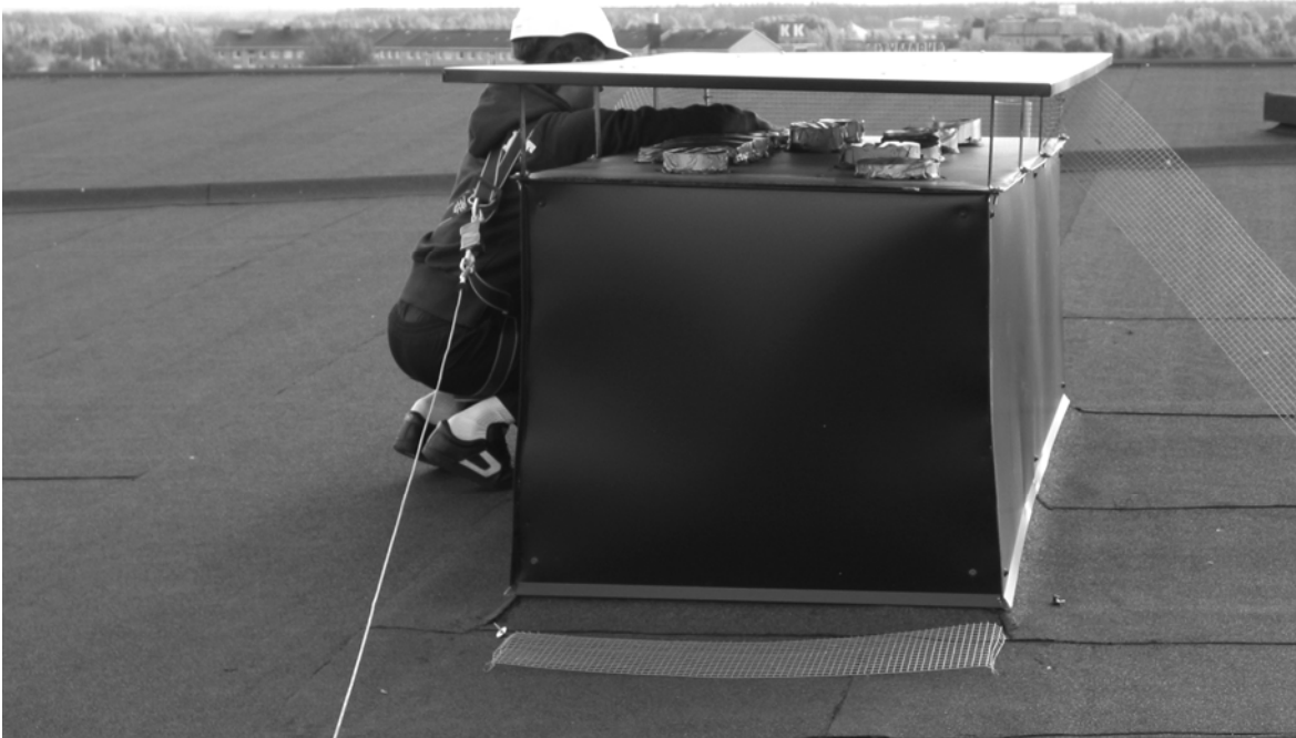
Kuva 2. Asuntojen poistoilmaputkien teippausta katolla.
