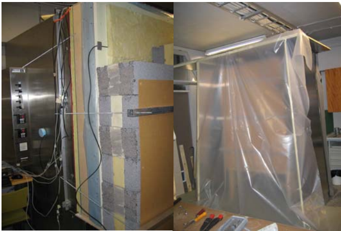
Kuva 6. Epästationaarisen kosteuskokeen koejärjestely: Lecaterm-harkkoseinä rakenteilla elementin lämpimälle puolelle (vasen) ja lopullinen koejärjestely (oikea).
