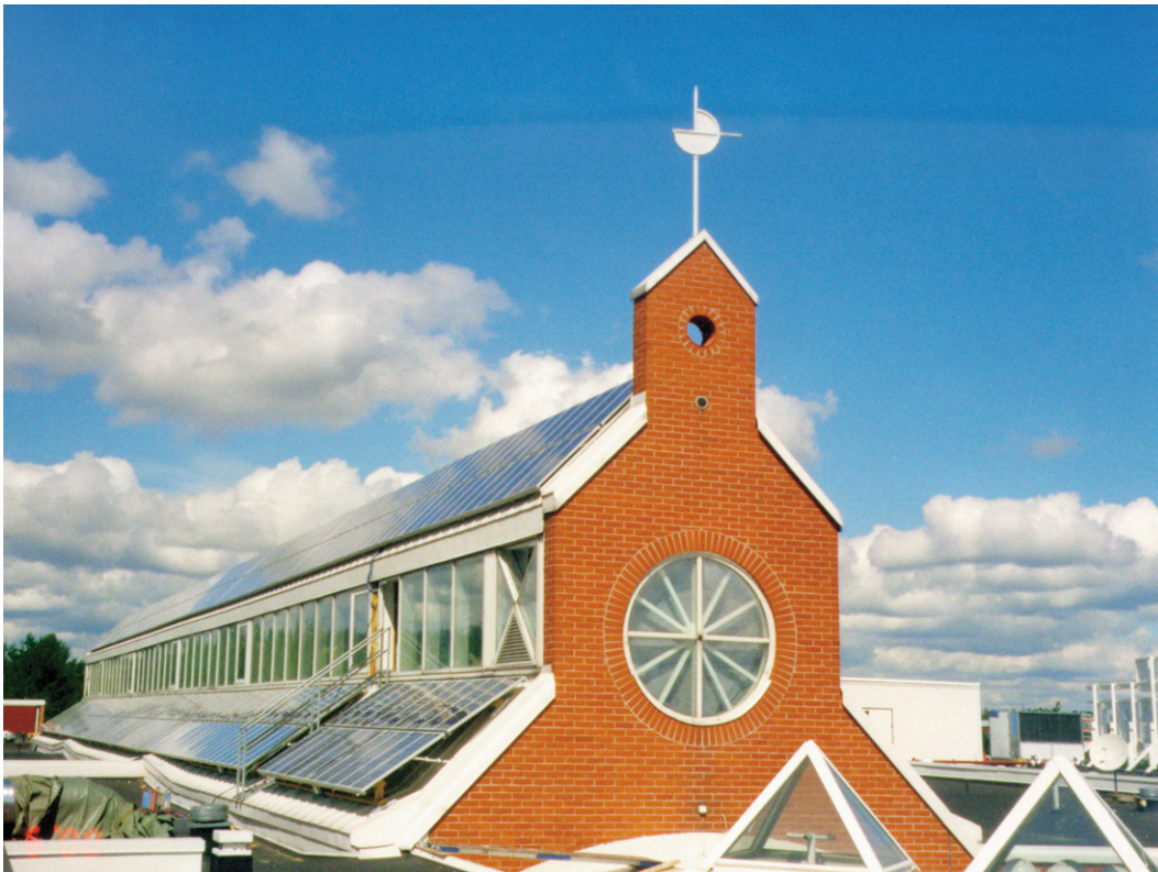
Kuva 1. Lielahden Citymarketin 39 kWp aurinkosähköjärjestelmä, Naps Systems Oy.
