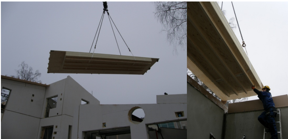
Kuva 3. SPU Passiivikattoelementtiä asennetaan betonirunkoiseen pientaloon.
