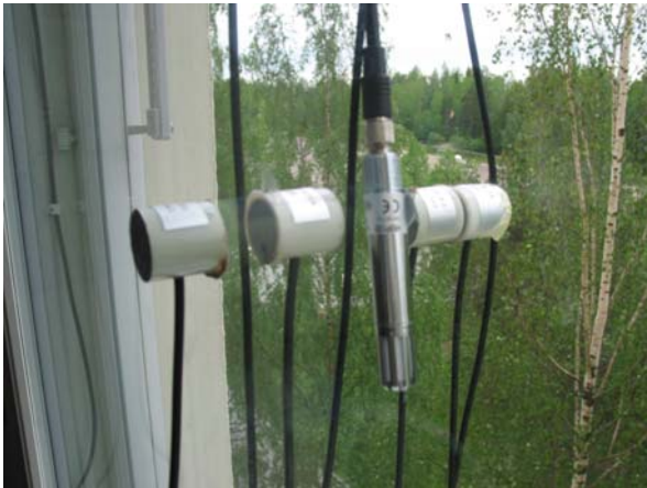
Kuva 5. Ikkunan keskikohta (mittauspiste B, ks. kuva 4). Kuvassa on näkyvissä lasin pinnoissa kiinni olevat pintalämpötila-anturit sekä ikkunan välitilan ilmassa oleva T/RH-anturi. Kuva keittiön MSE-ikkunasta. [1]
