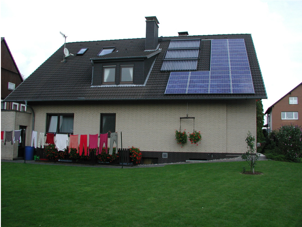
Kuva 2. Naps Systemsin aurinkosähköjärjestelmä pientalon katolla Saksassa.
