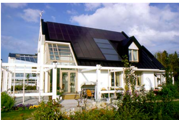
Kuva 2. Aurinkotalo IEA5 rakennettiin 1993 – 1994 ja esiteltiin yleisölle Pietarsaaren asuntomessuilla 1994. Rakennuksen ostetun energian kokonaiskulutus on vain 48 \text{ kWh/m}^2 .
