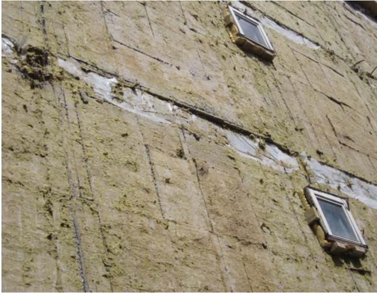
Kuva 2. Purettu, painepesty vanha seinärakenne.
