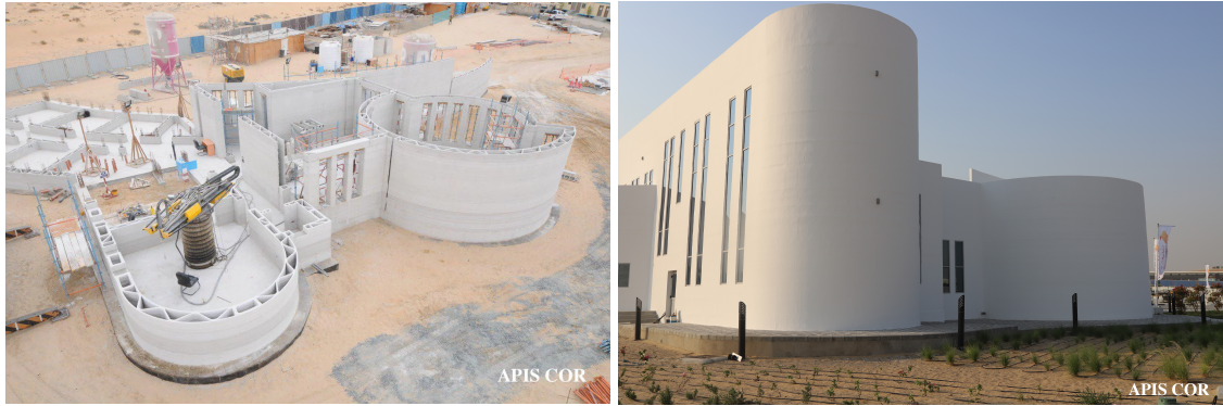
Kuva 3.4. 3D-tulostettu rakennus keskeneräisenä ja valmiina [19].
