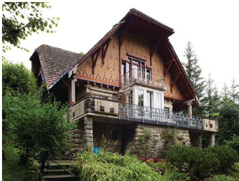
Fig. 3: Le Corbusier, Villa Fallet, La Chaux-de-Fonds, 1905.
