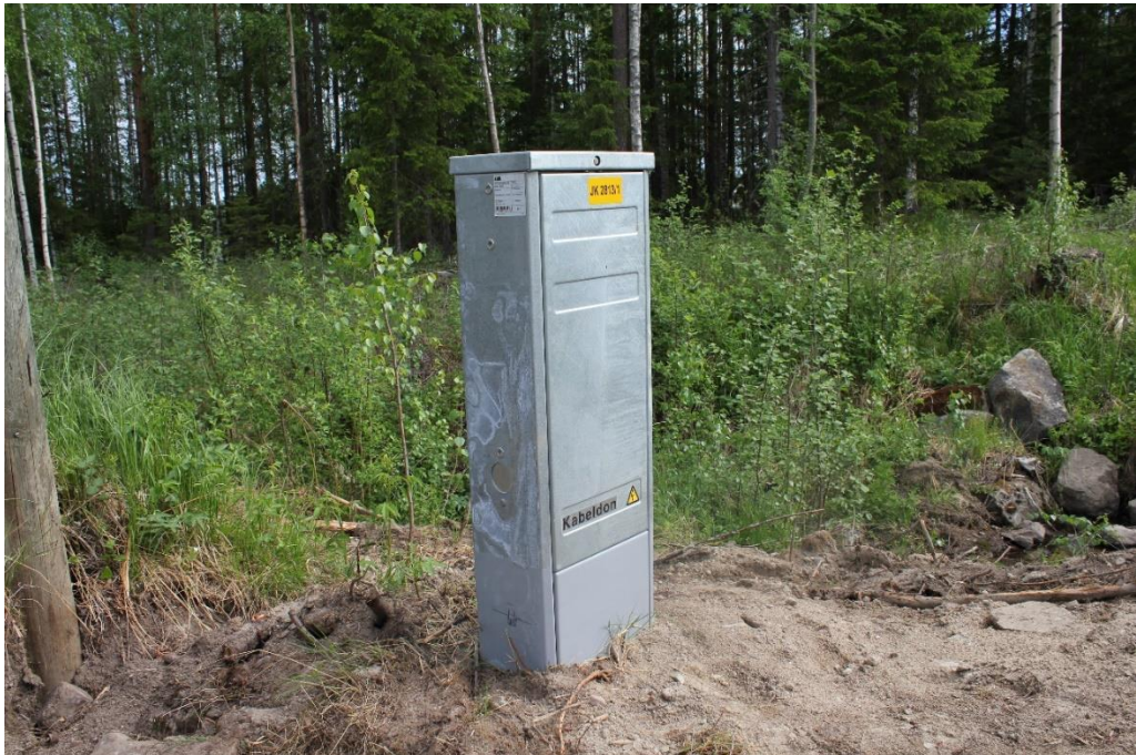
Kuva 9: Pienjännitteisen maakaapeliverkon jakokaappi
