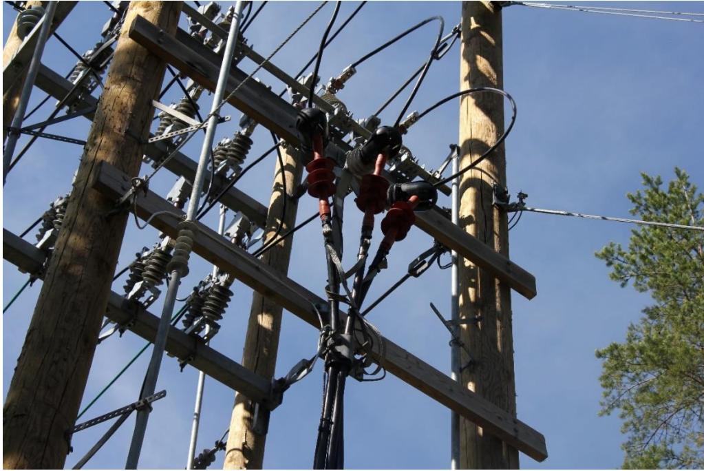
Kuva 7: Keskijänniteverkon pylväspäät
