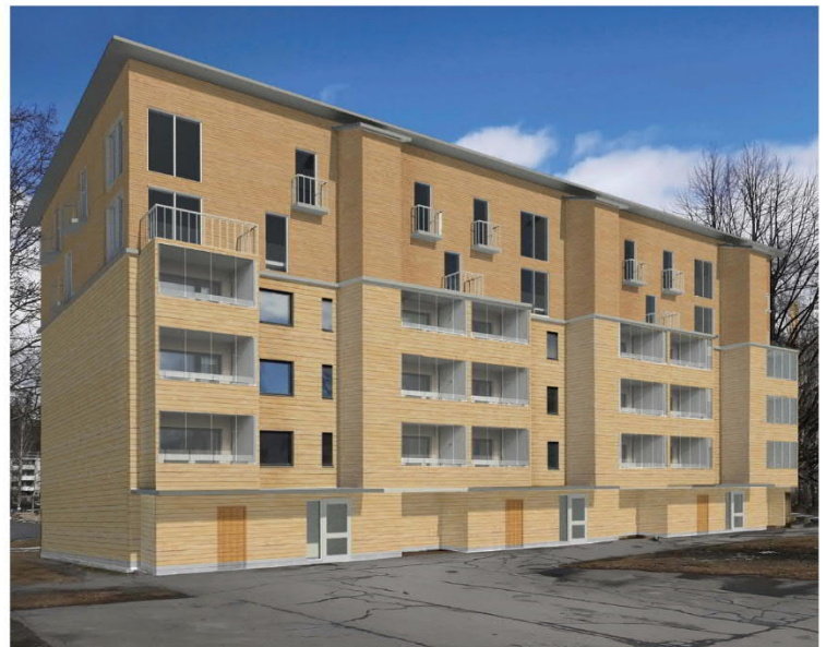
Kuva 6. Puuverhous, 2-lisäkerrosta ja uudet hissit
