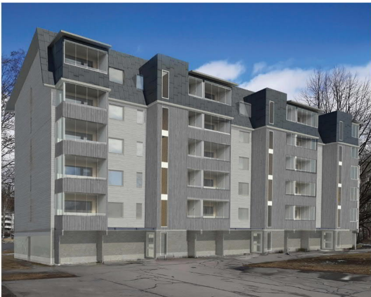
Kuva 5. Puuverhous, 2-lisäkerrosta ja uudet hissit
