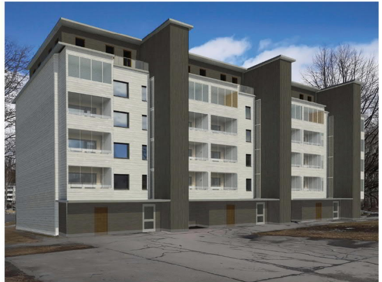
Kuva 4. Puuverhous, 2-lisäkerrosta ja uudet hissit
