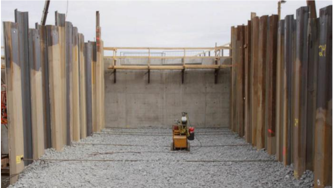
Kuva 6. Vaahtolasia käytetään kuvassa ponttiseinän taustatäyttönä. (Foamit.fi 2020)
