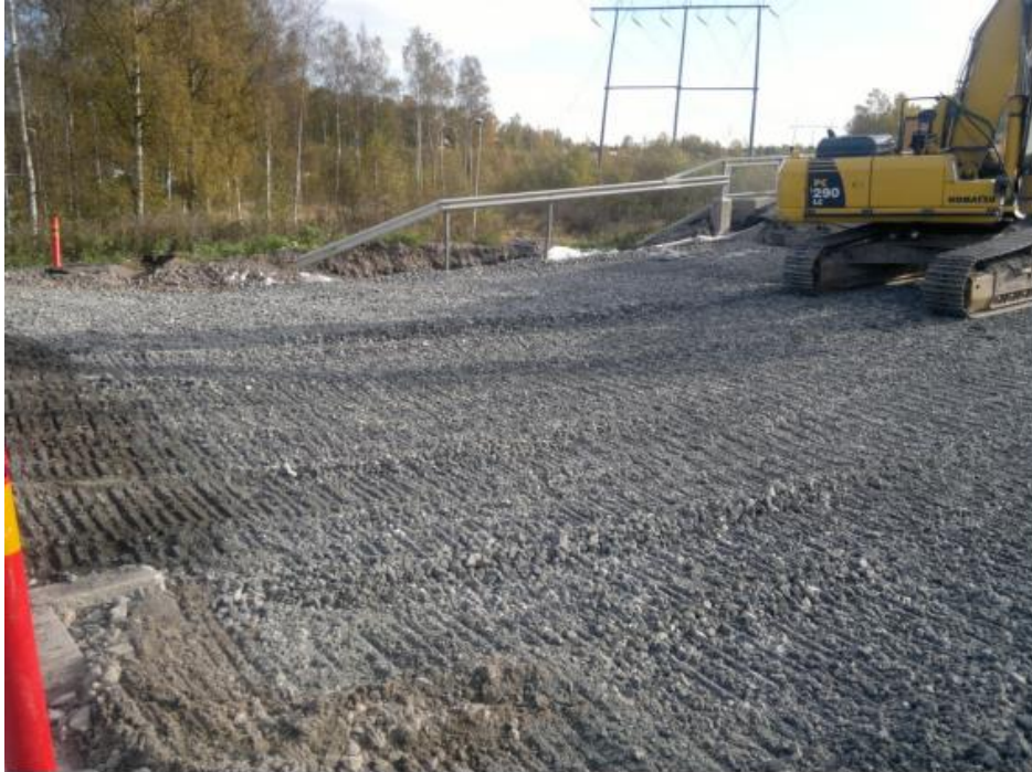
Kuva 4. Esitiivistystä tehdään telakalustolla. Vaahtolasikerros ei ole riittävän tiivis, sillä yliajoista jää vielä telan jälkiä. (Kuisma 2013, s. 7)
