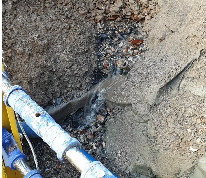
Kuva 15. Jätevesiviemärin alla sijaitseva teräsbetoniarina kaivannosta kuvattuna (Mäkinen, henkilökohtainen tiedonanto 15.5.2020)
