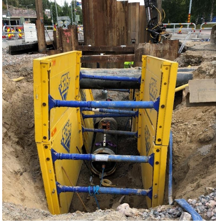
Kuva 13. Kaivannon tukeminen tuentaelementillä, joka oli valittu alustavaksi tuentatavaksi paaluvälillä 0-30 (Mäkinen, henkilökohtainen tiedonanto 15.5.2020)
