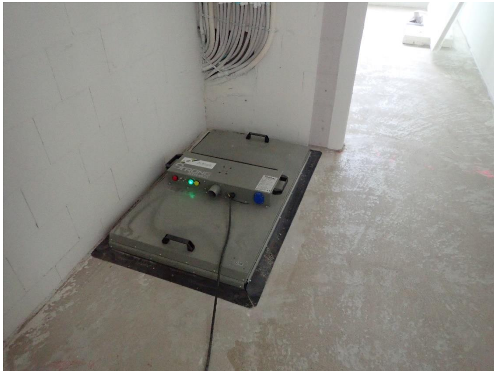
Kuva 10. Kohteessa B käytettiin levykuivaimia yksittäisten alueiden kuivaamiseen
