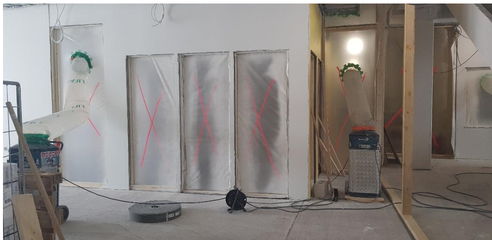
Kuva 16. Sisärakennusvaiheessa kohteen C osastoinnit oli toteutettu hyvin
