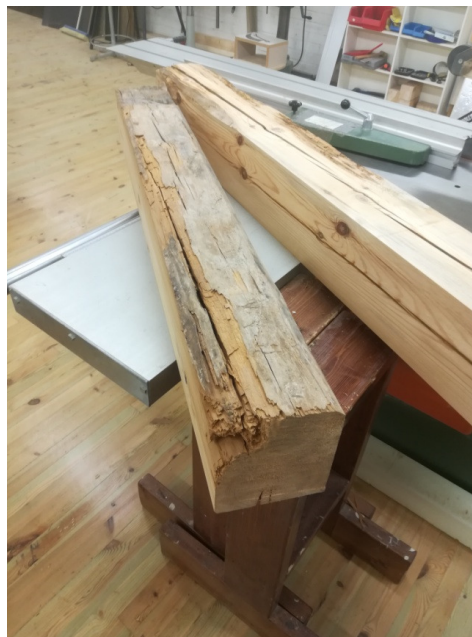
Kuva 5.5. Vanhan puutavaran lahovaurioita ja oikosahattua pintaa.
