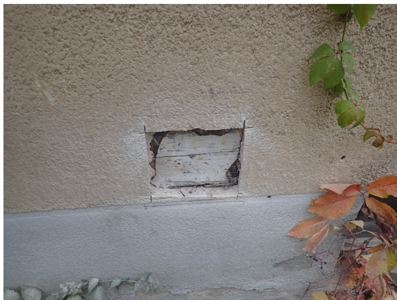
Kuva 7.4. Hirsirungon sokkeliliittymän tyypillinen avauskohta. [32]
