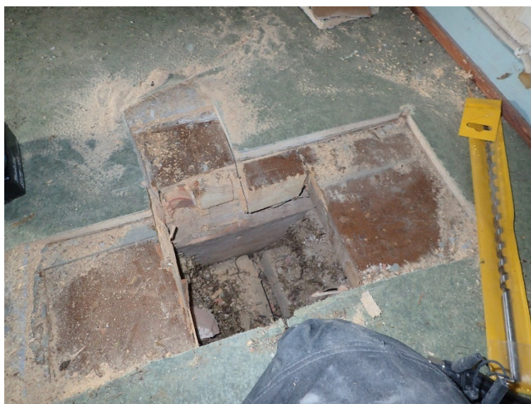
Kuva 7.7. Vallisaaren Luotsitalon välipohjan tyypillinen avauskohta. [32]
