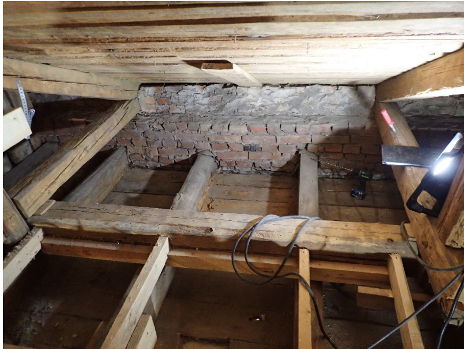
Kuva 7.2. Yläpohjan ja vesikaton puurakenteita. [32]
