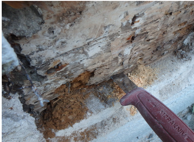
Kuva 3.4. Hirsirungon alaosan kapillaarikatkon puuttumisesta johtuva lahovaurio. [32]
