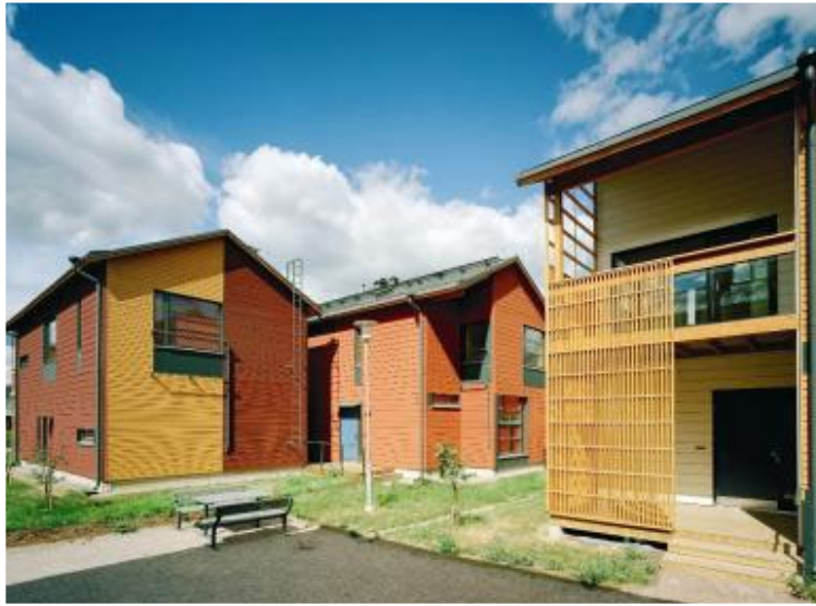
KUVA 29: AS OY JOKINEITO, YLEISNÄKYMÄ.
