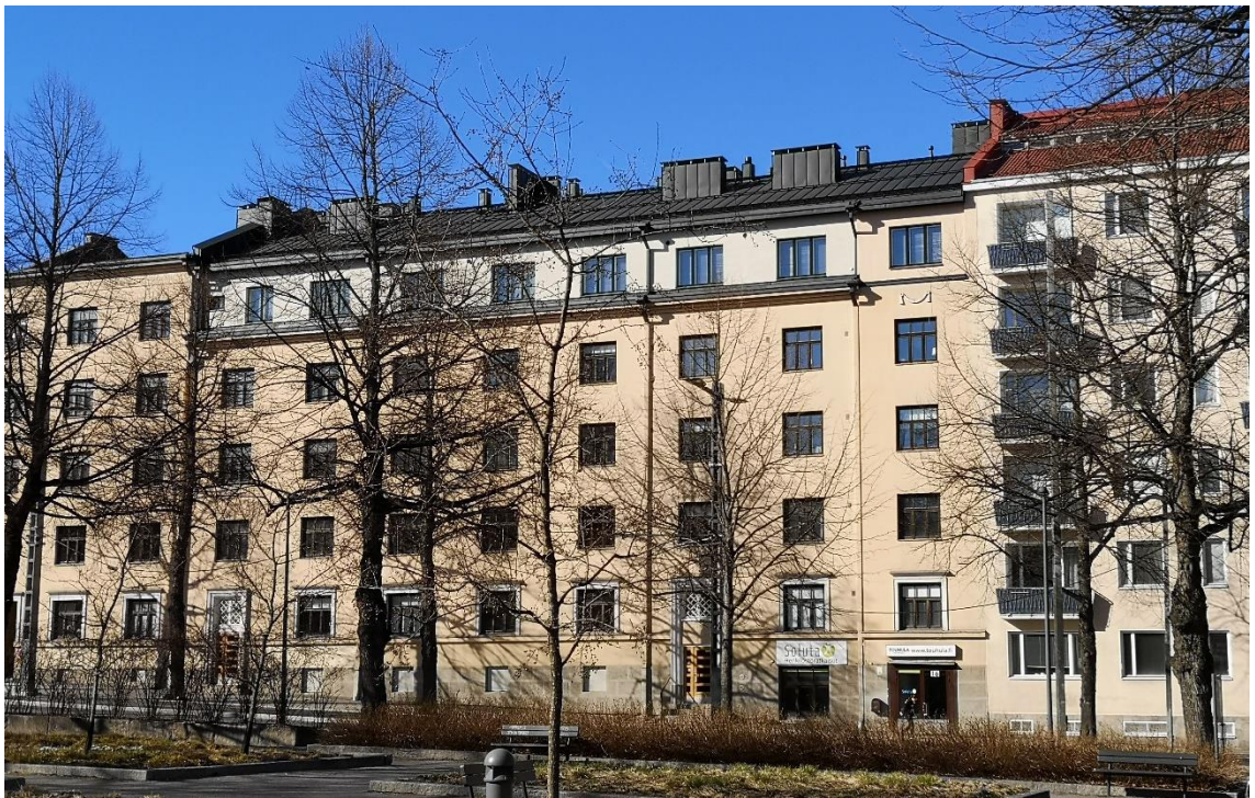
Kuva 2. Pirkankatu 16, Sulkavalan talo. Kuvassa kattorakentamiskohde Pirkankadulla, jossa kattoasunnot ovat osa muurimaista korttelikonaisuutta. Ympäristönsä sopeutuva korotus viittaa mittasuhteiltaan ja julkisivumateriaaleiltaan vanhaan rakennukseen.
