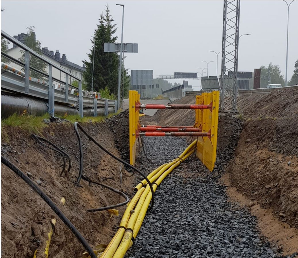
Kuva 6. Kaivantotukielementeillä osittain tuettu kaukolämpökaivanto. [29]
