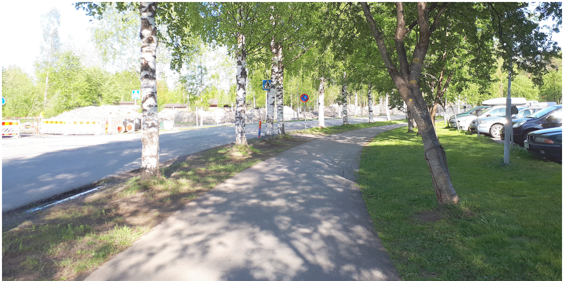
Kuva 26. Puutteellinen kevyen liikenteen opastus väliaikaiselle suojatielle.
