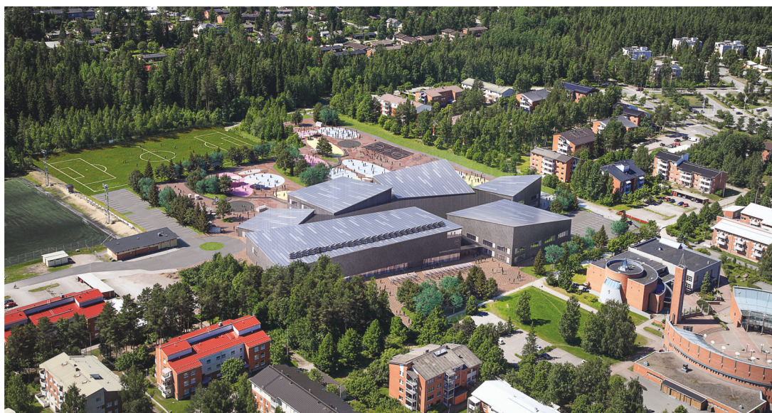
Ilmavasarvite. Näkymä koilliseen.
