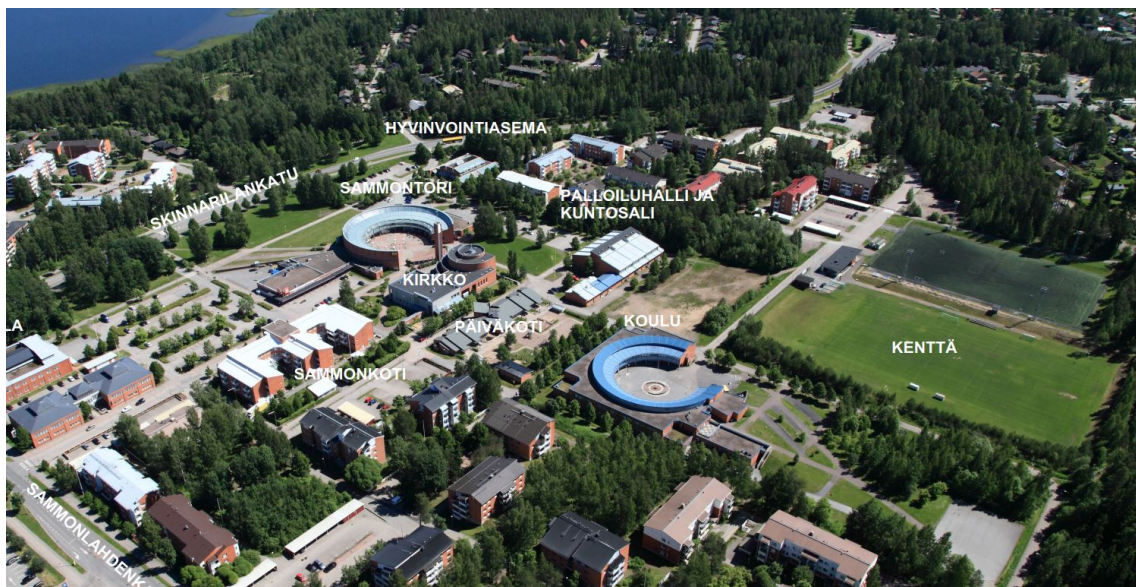
Kuva 5. Suunnittelualueen lähtötilanne. Purettavat rakennukset; pyöreä koulu, päiväkotiki ja palloiluhalli.
