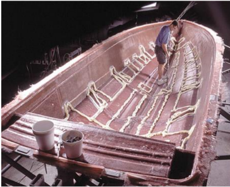
Kuva 17: Liima levitetään veneen runkoon ennen laipion asettamista. Kuva Plexus [2, s. 1396].
