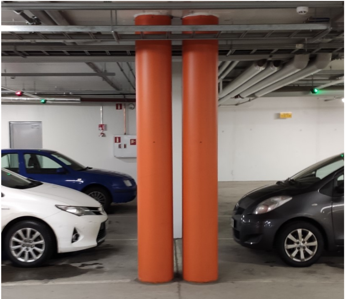
Kuva 5. Vierekkäiset kantavat pilarit.
