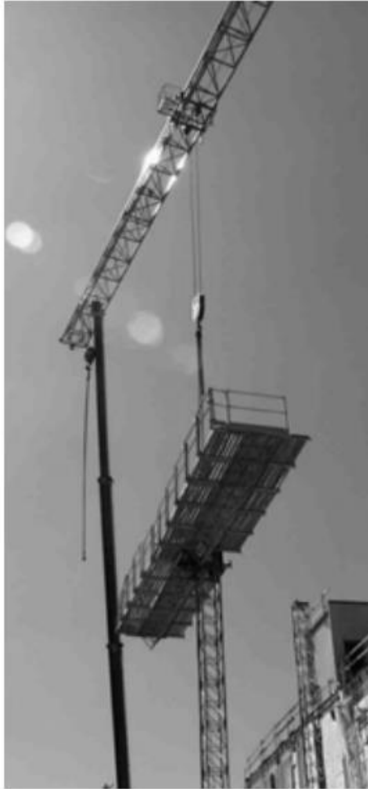
Kuva 3. Torninosturi siirtämässä mastolavaa [8, s. 23]
