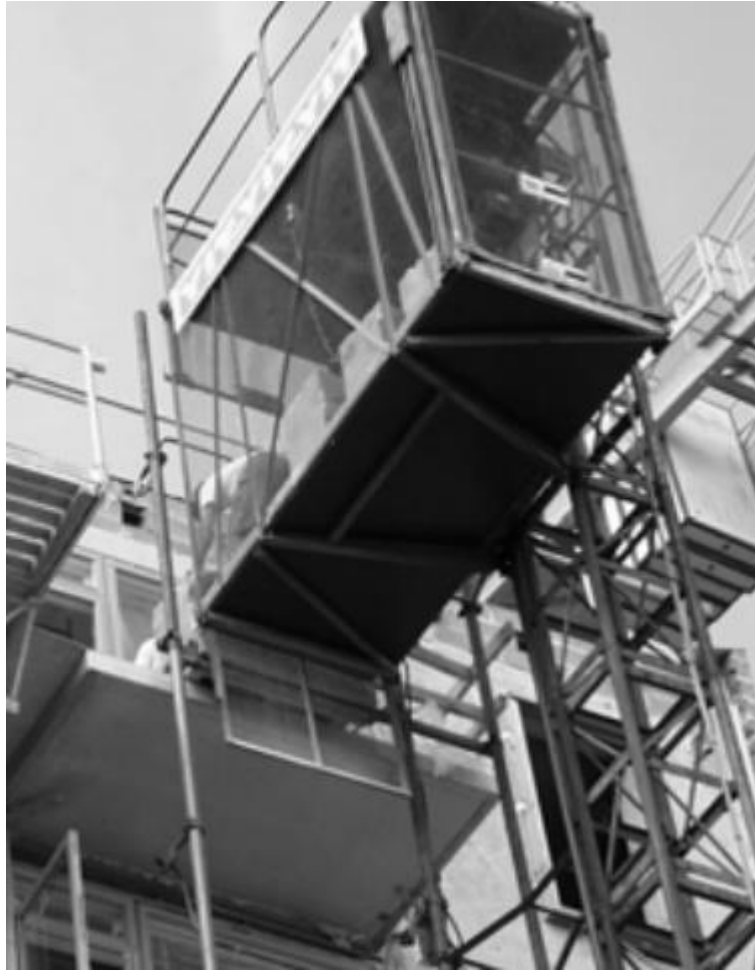
Kuva 2. Materiaalien siirto parvekkeelta mastolavalle [8, s. 14]
