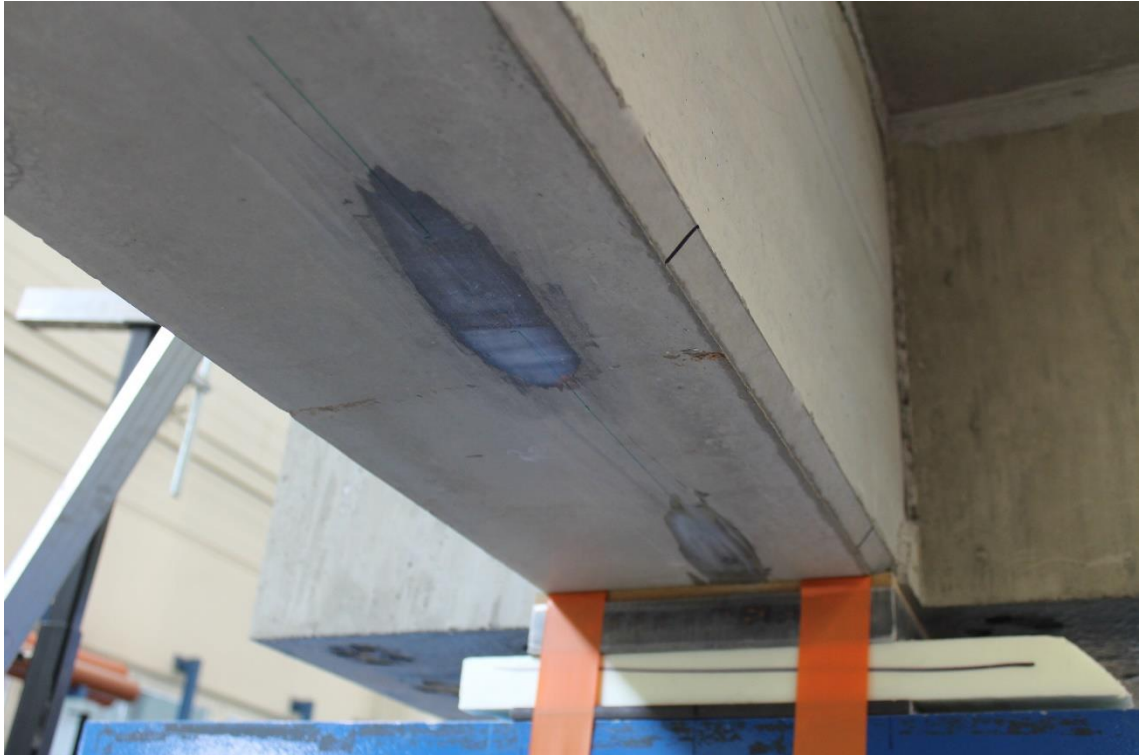
Kuva 55. Betoniliuskojen mittapistekohtien esikäsitely EP-340-liimalla.
