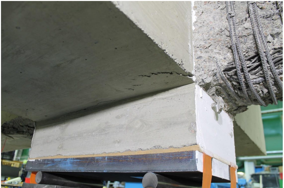
Kuva 90. Jatkosalueen ja pilarivalun halkeilua, sekä palkkien raudoituksen muodonmuutokset JK12-koekappaleessa.
