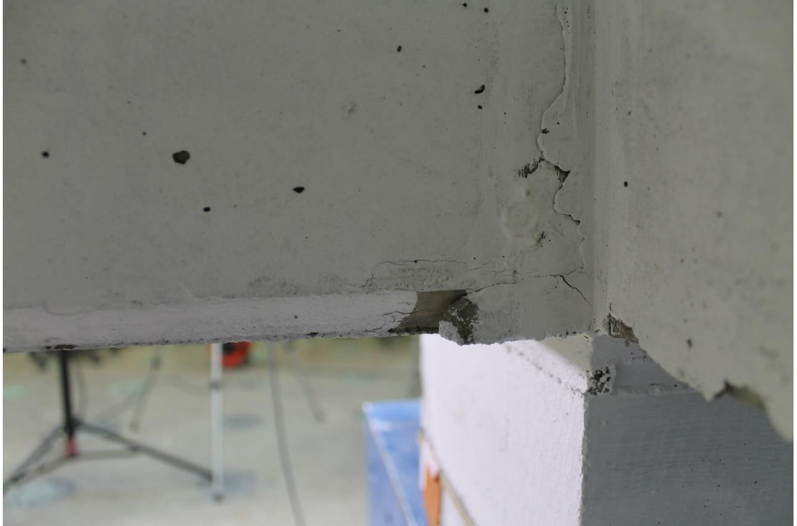
Kuva 86. Halkeama JK12-koekappaleessa kuormaportaalla 500 kN.
