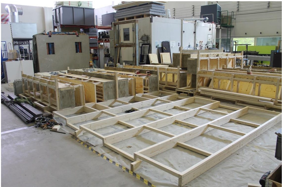
Kuva 45. Toisen vaiheen valumuotit.
