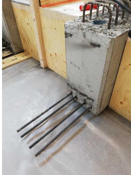
Kuva 29. Elementtipalkin taitettavat jännepunokset.
