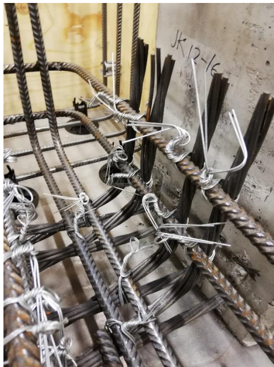
Kuva 35. Jännepunosten sidonta raudoitushäkkiin.
