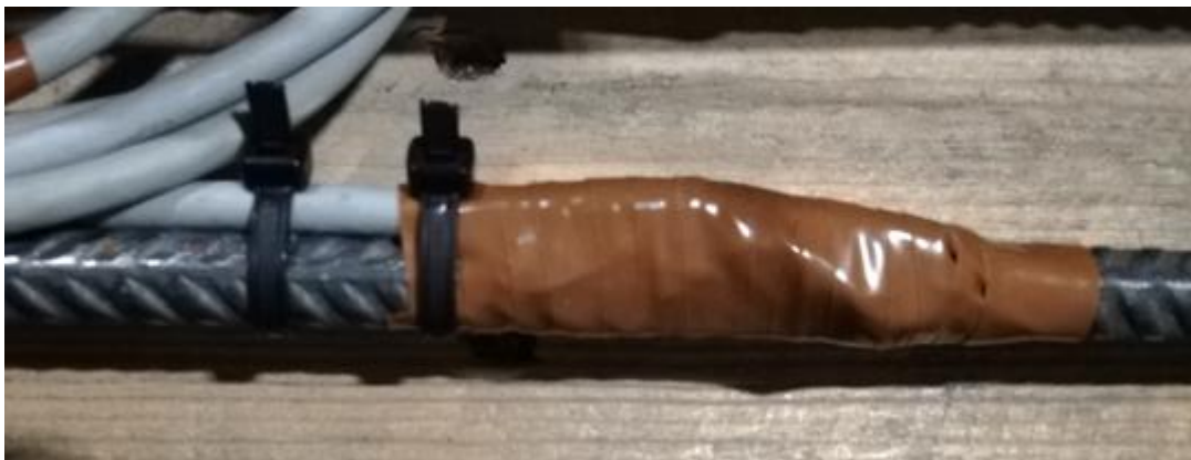
Kuva 17. Kytkentöjen suojaaminen.
