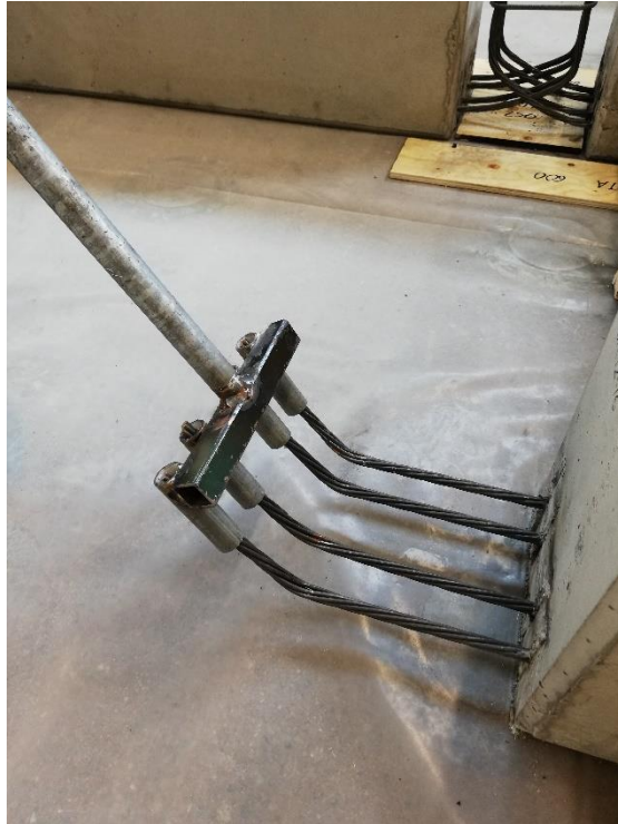
Kuva 31. Jännepunosten samanaikainen taivutus.
