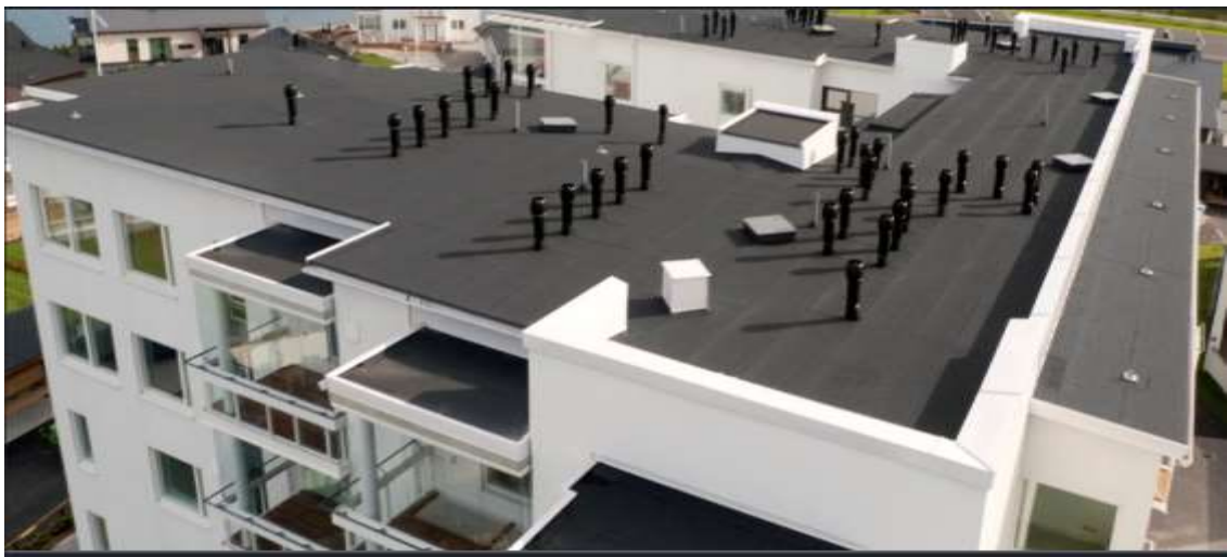
Kuva 2. Tiivissaumakate kerrostalorakennuksessa (Kerabit 2019b).
