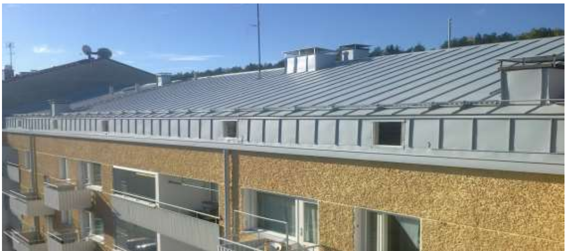
Kuva 1. Konesaumattu peltikate kerrostalorakennuksessa (Rakennuspelti H.Turpeinen Oy 2013).
