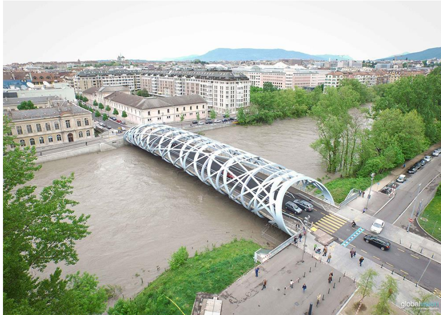
Kuva 2. Hans-Wilsdorf-silta Genevessä (GlobalVision Communication 2015)
