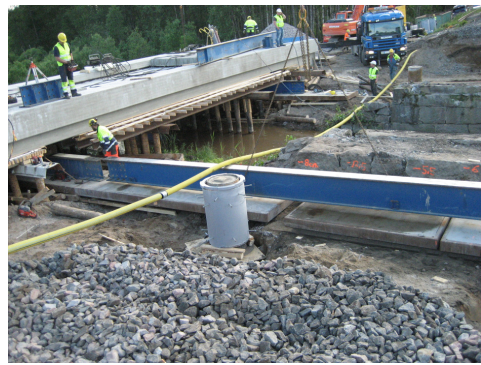
Kuva 3.2 Sillan siirtämisestä edeltävät työvaiheet. Valokuvassa työvaiheena siirtoratojen asennus.
