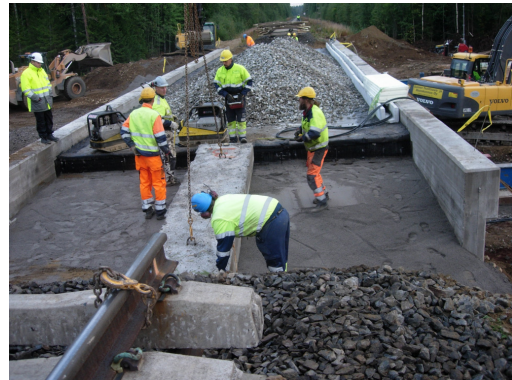
Kuva 3.4 Sillan päiden täytöt sekä siirtymälautojen asennus. Valokuvassa työvaiheena siirtymälautojen asennus.
