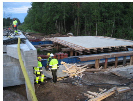
Kuva 3.3 Sillan siirtäminen. Valokuvassa silta on siirretty valualustalta lopulliselle paikalleen.
