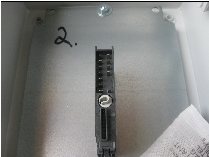
Kuva 6.11. Kytentäkotelon 2 sisältä, ei havaittavaa kosteutta.
