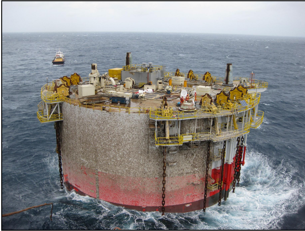
Kuva 3.16. Spar-lautan runko paikoillaan ja odottaa tuotantomoduulin asentamista.
