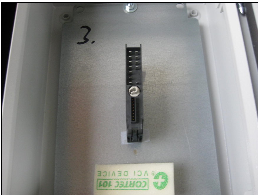
Kuva 6.13. Kytentäkotelon 3 sisältä, ei havaittavaa kosteutta.
