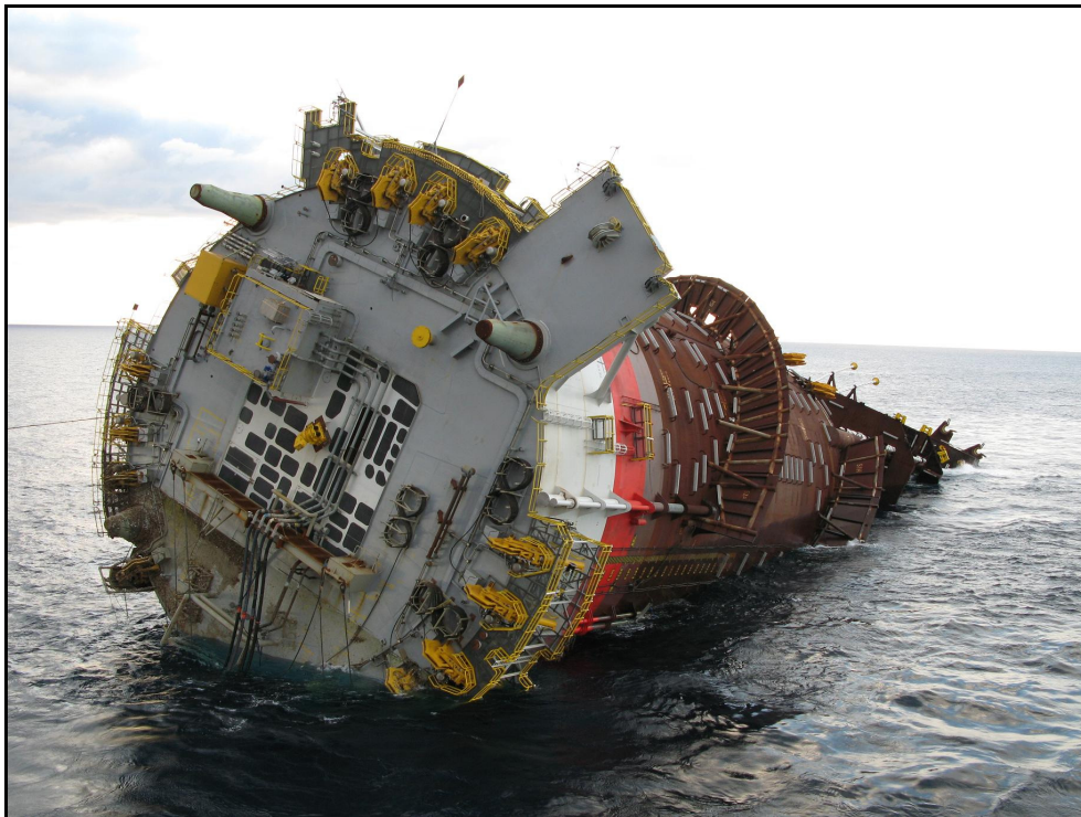
Kuva 3.15. SPAR-lautan rungon nosto paikoilleen Meksikonlahdella.
