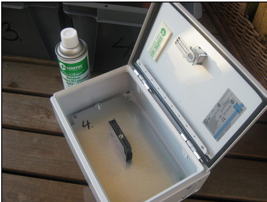
Kuva 6.2. I/O-kortti on kiinnitettyä kaksipuolisella teipillä kytkentäkotelon taustalevyyn.
