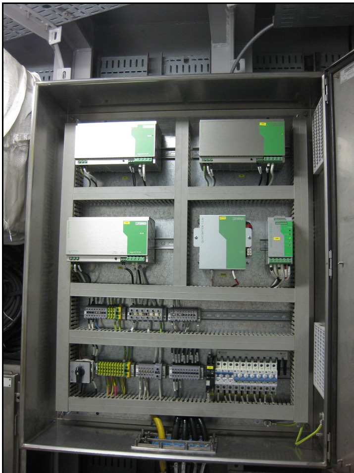
Kuva 3.6. Kolme kappaletta hakkurivirtalähdekoteloita sekä UPS.
