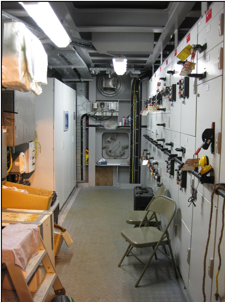
Kuva 3.3. Kansimökki sisältä kuvattuna, edessä ylhäällä näkyy tuuletuskone. Kansimökin katolla sijaitsee ilmastointilaite.
