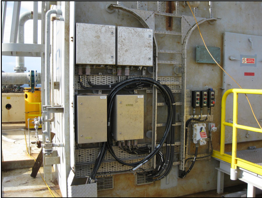
Kuva 3.7. Kansimökin seinällä olevia kytkentäkoteloita, joiden suojaluokitus on IP56. Kaappien ovissa ja kansimökin seinällä näkyy jo runsaasti ruostetta.
