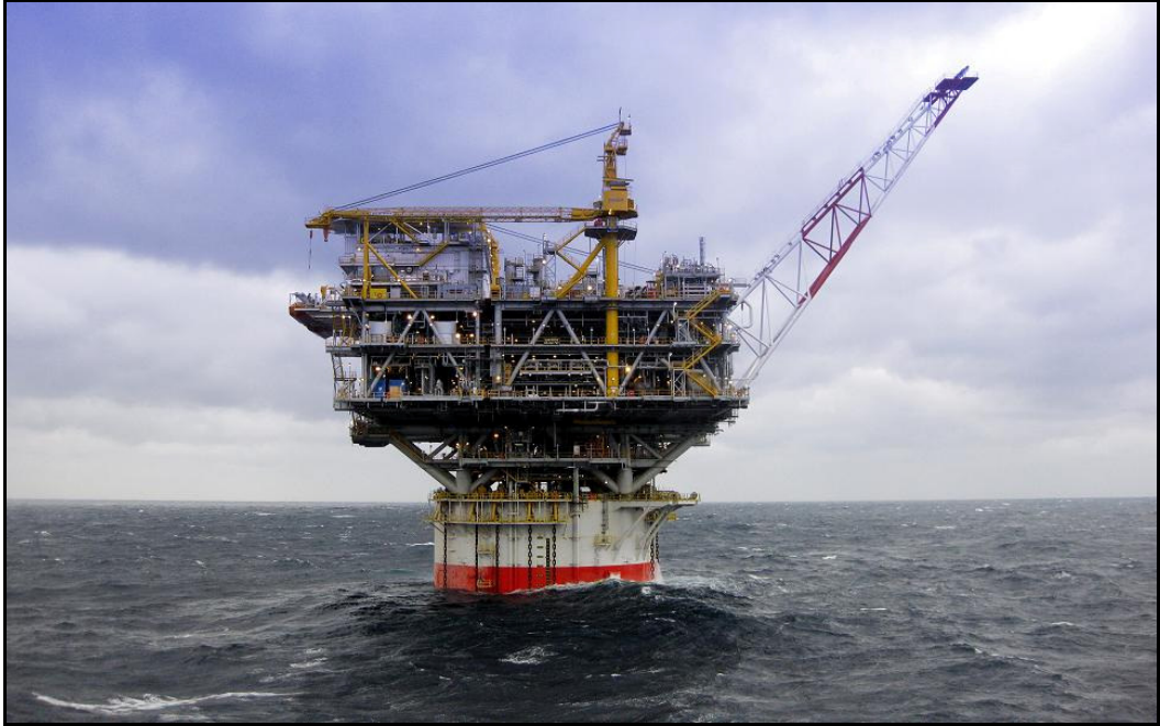
Kuva 3.1. Öljy-yhtiö Chevronin Tahiti-niminen spar-öljyntuotantolautta.
