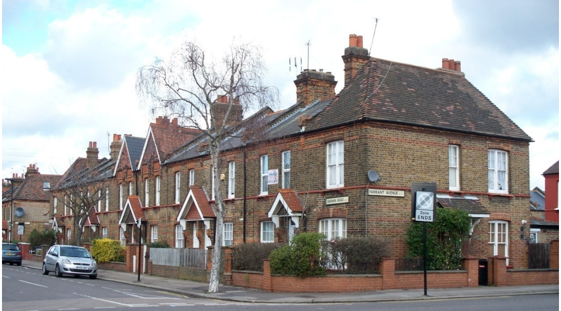
kuva 43: Neljännen luokan taloja, Darwin Road, Noel Park, Lontoo.
