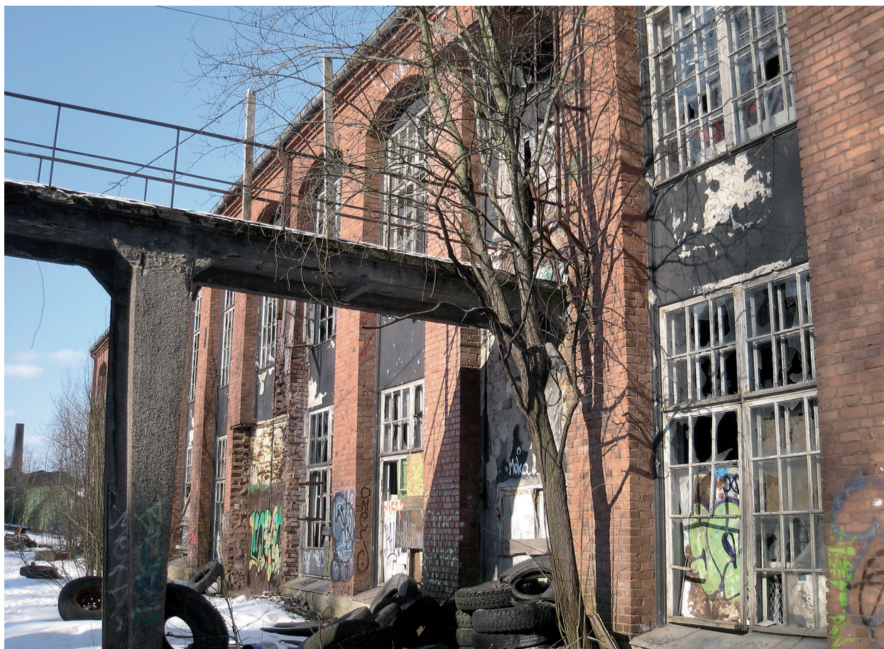
VIEREISEN SIVUN KUVA: AARNE SARVELAN 1926 SUUNNITTELEMA OKT:N TULITIKKUTEHDAS. YLLÄ: SILTA JOHTAA TEHTAAN RUUTIVARASTOLLE. RENKAAT OVAT JÄÄNEET TEHTAASSA VIIMEISENÄ TOIMINEEN AUTOKORJAAMON POISTUTTUA.
