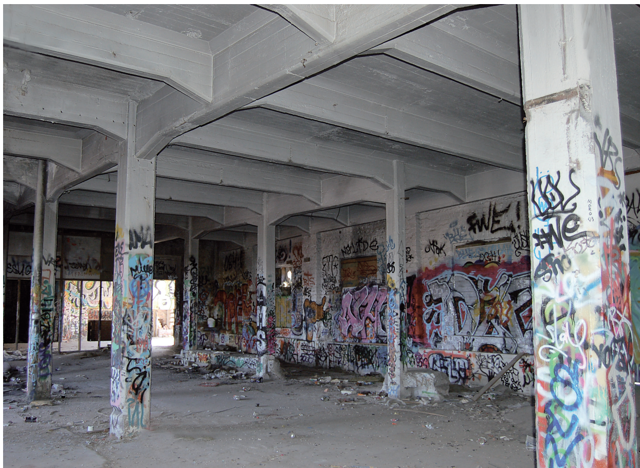
KATTOHUOPATEHTAAN VANHAN TEHDASSALIN RAKENTEITA ALLA: KAAREVAA SEINÄLINJAA.
