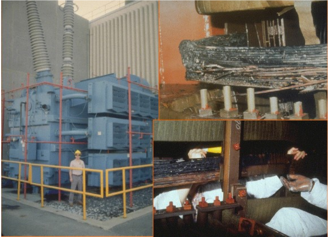
Kuva 4: Vuoden 1989 geomagneettisessa myrskyssä vaurioitunut muuntaja Salemin ydinvoimalalla. Oikeanpuoleiset kuvat ovat muuntajan vaurioituneesta 22 kV alajännitekäämityksestä. [17, s. 2-33]
