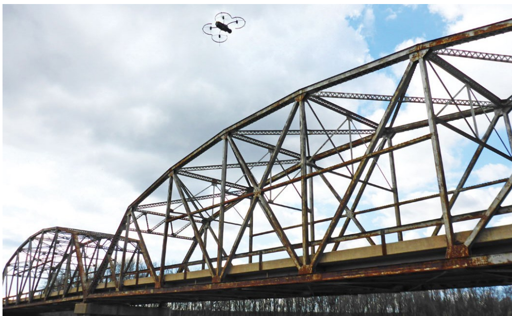
Kuva 27, Drone kuvaamassa sillan rakenteita (Dronesglobe, 2019)
