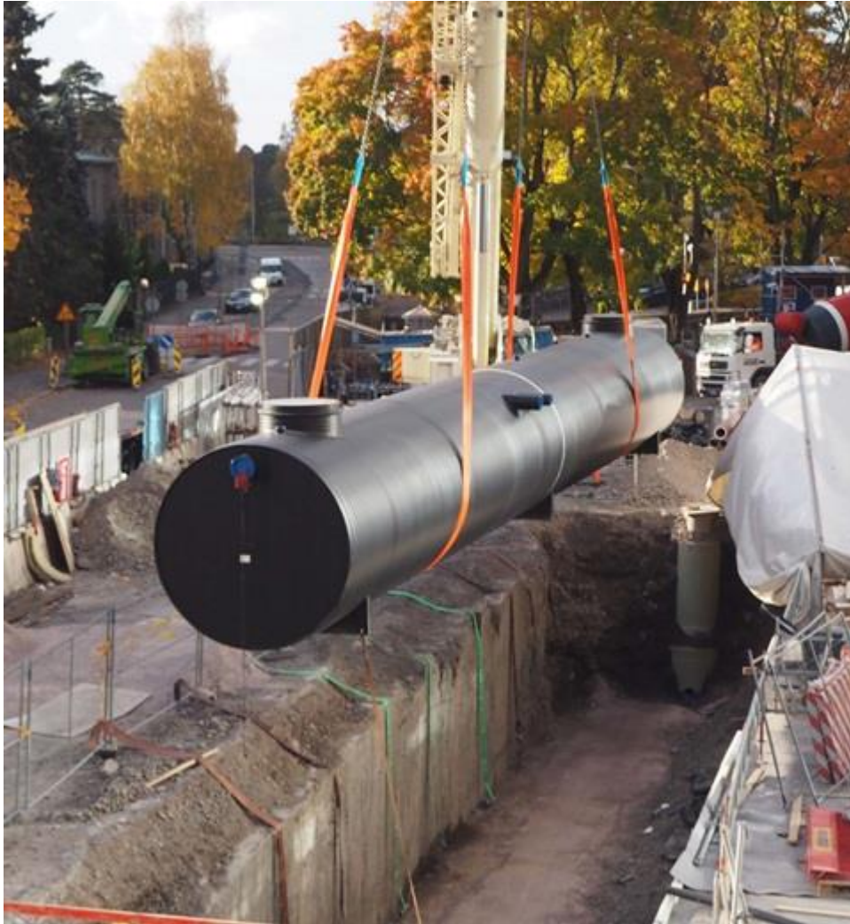
Kuva 4. Esimerkki isosta viivytyssäiliöstä. Viivytyssäiliöitä käytetään virtaaman tasaamiseen, kun maankäyttö on liian tiivistä allas- tai lampirakenteelle.
