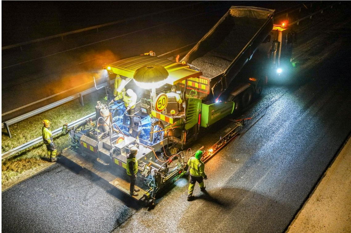
Kuva 1. Asfaltinlevittäjä (Kuva: Asfalttikallio Oy 2017).
