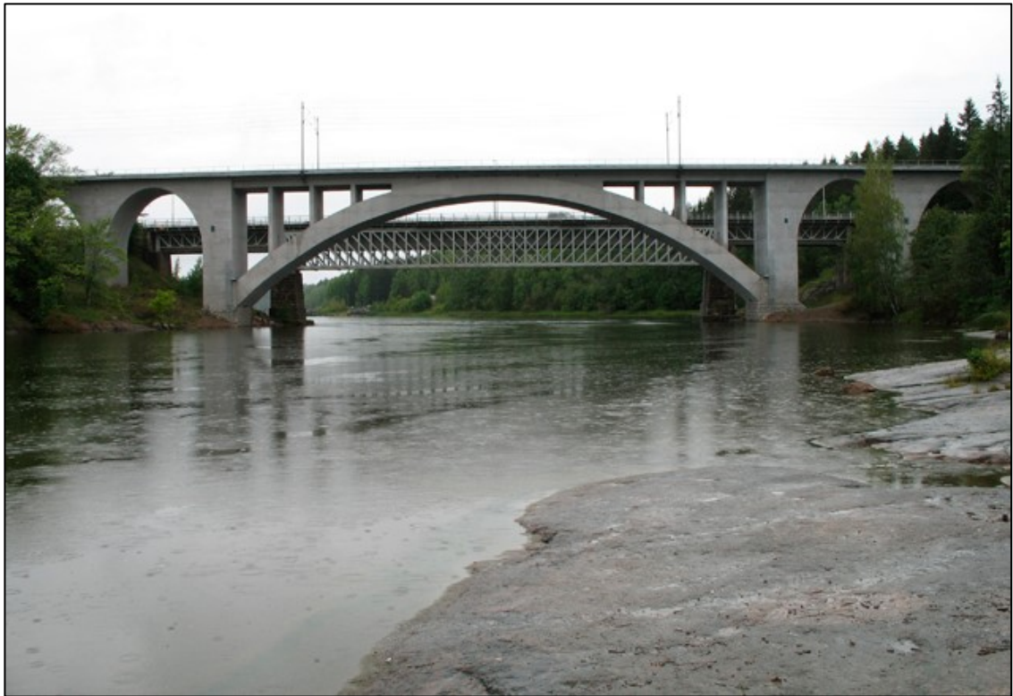
Kuva 2.11 Kymijoen ylittävät Korian ratasillat. Etualalla 1920-luvun teräsbetoninen holvisilta ja takana vanha teräsristikkosilta 1870-luvulta, joka toimii nykyään kevyen liikenteen käytössä [23].
