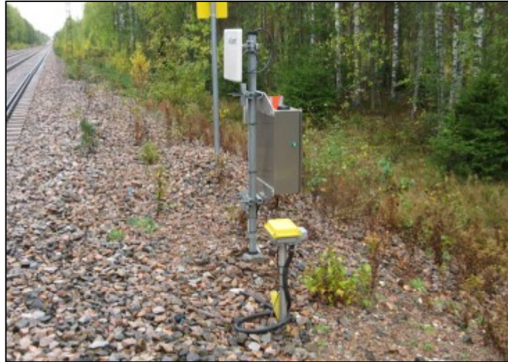
Kuva 3.3 RFID-antenni ja kytkentäkotelo [26].
