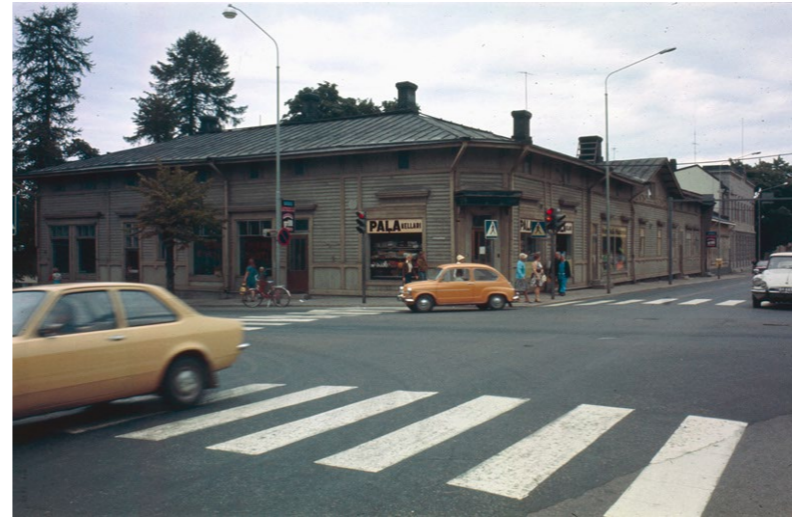
Kuva 27: Purettu liikerakennus Koulu- ja Kauppakadun kulmassa - Tuntematon valokuvaaja 1975, Lappeerannan museot.
