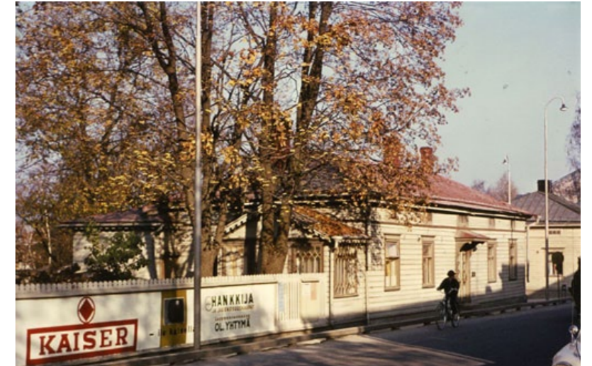
Kuva 30: Virastotalon tontilta purettu työväenopiston rakennus - kuvaaja Nikulainen Pentti 1959, Lappeerannan museot.
