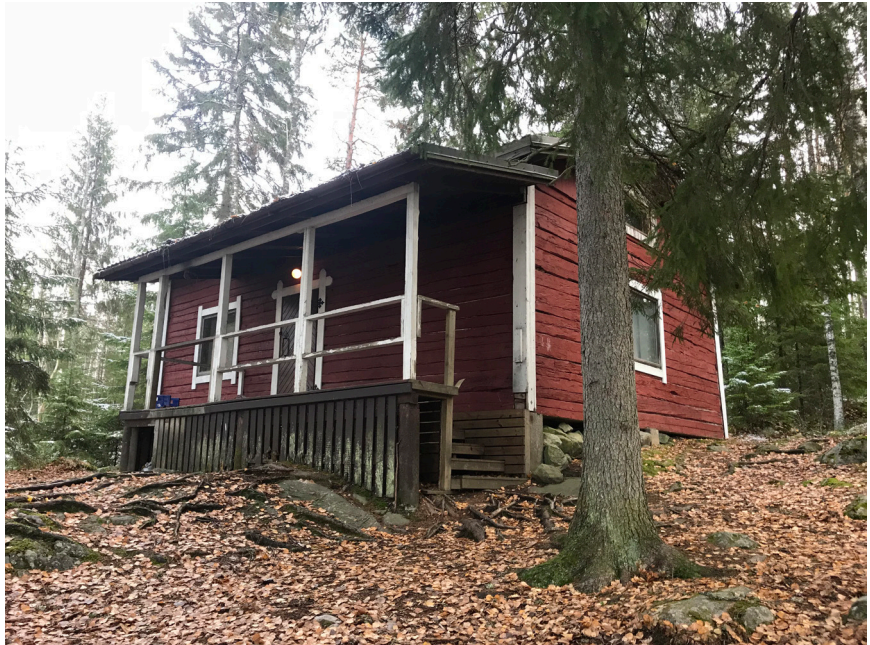
Järven itärannalla, noin 200 metriä leirikeskukselta pohjoiseen, sijaitsee vanha hirsirakenteinen sauna- ja tuparakennus nuotiopaikkoineen.
