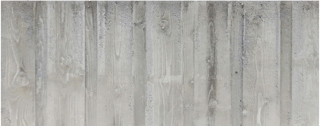
Yllä sokkelin valumuotin muottikaavio. Alla valmis betonipinta joka toistaa vesikaton lautakuivion.
