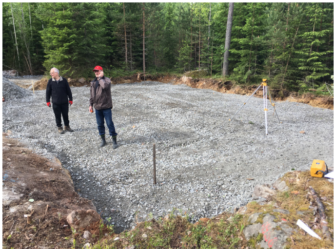
Talkooryhmän avainhenkilöt, Timo Viitanen (vasemmalla) ja Timo Haavisto, tarkastusmittaavat maatäytön korkoja.
