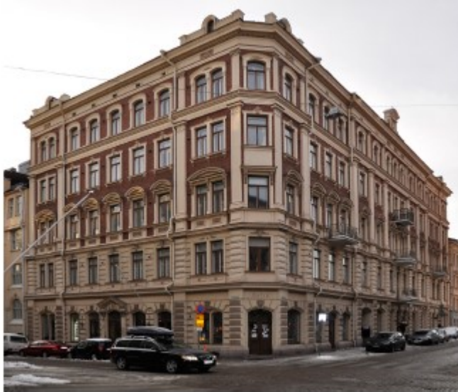
Kuva 13. Rakennuksen julkisivu Korkeavuorenkadulta katsottuna [134].
