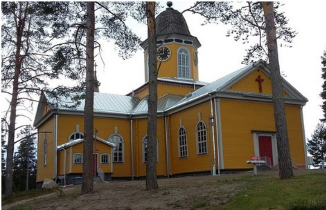
Kuva 15. Korpilahden kirkko korjaus- ja muutostyön valmistuttua [151].
