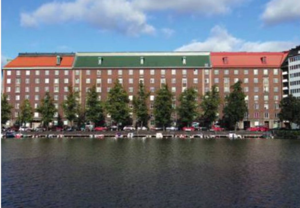
Kuva 12. Toteutettu kattoikkuna vihreä kattoisen rakennuksen oikeassa reunassa, kuva Lauri Jääskeläinen [133].
