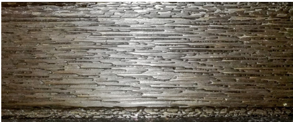
Kuva 52. Sulatuskuljettimen pohjan kuluminen kuljettimen alkupäässä.
