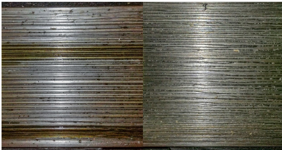
Kuva 50. Sulatuskuljettimen t-palojen kuluminen.
