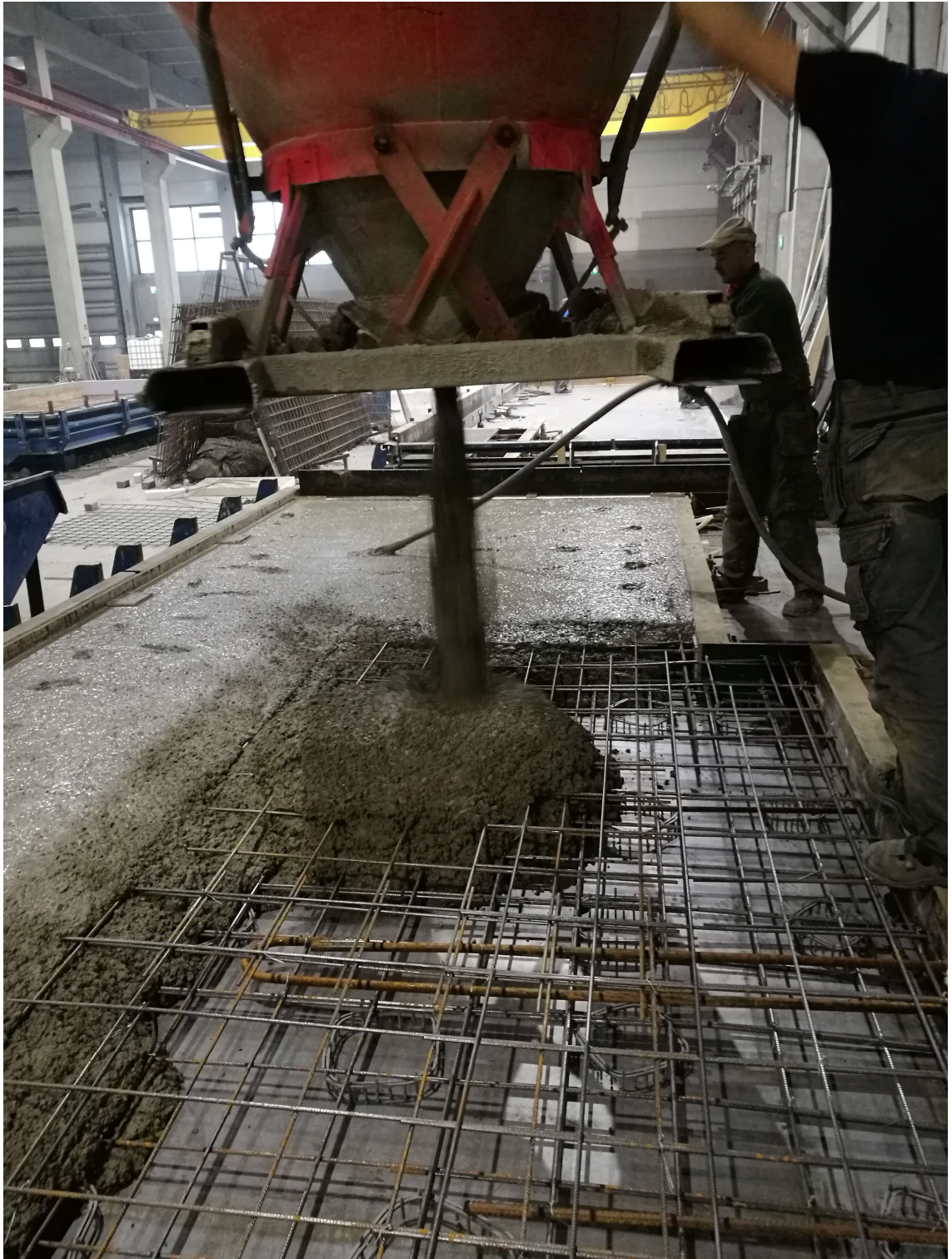
Kuva 13. Betonointia
