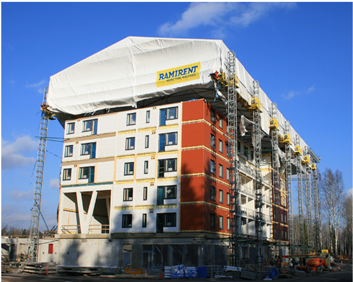
Kuva 18. Rakennuksen ylle asennettu sääsuojatelta (Ramirent 2018)
