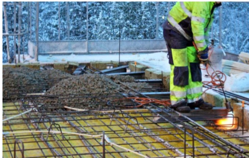
Kuva 2. Muotissa olevan lumen ja jään sulatus [3, s. 34].
