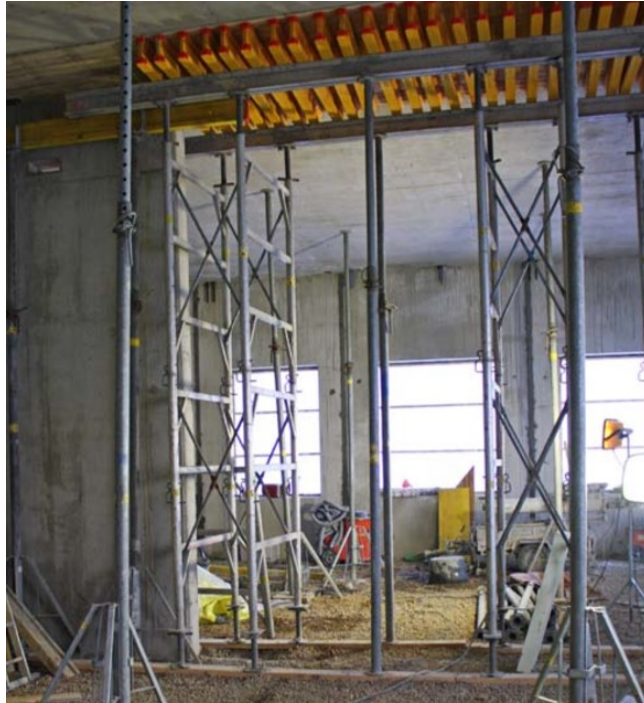
Kuva 3. Betonin tulee saavuttaa purkulujuutensa ennen tukien purkamista [3, s. 19].
