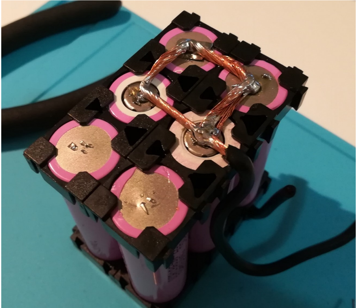
Kuva 8. Vaunun akusto rakennusvaiheessa.
