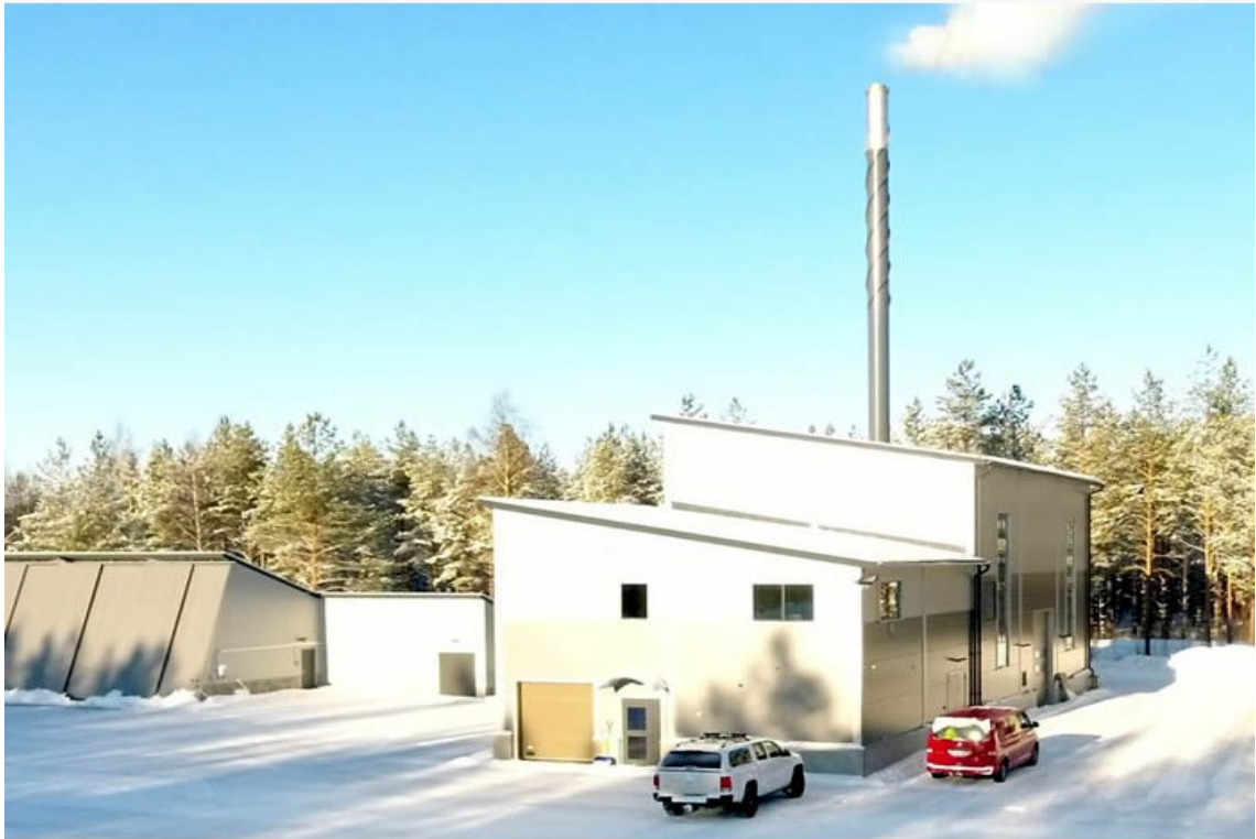
Kuva 3. 4MW:n biolämpölaitos, Halli [5].
