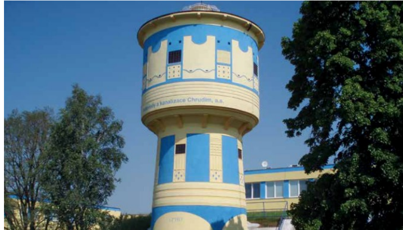
Kuva 6. Esimerkkikohteena vesitorni Chrudimissa (Tshekin tasavalta), joka suojattiin ja vesieristettiin BASF:n tuotteilla. Hanke valmistui vuonna 2008. [10]
