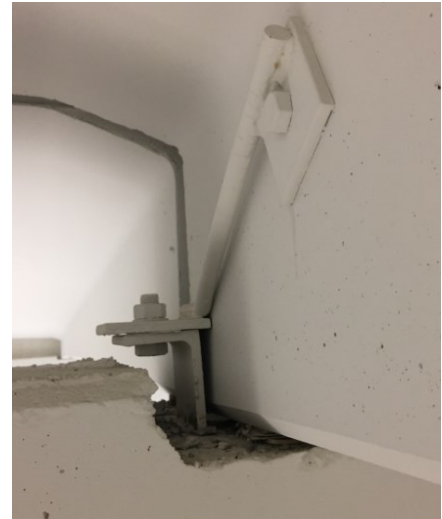
Kuva 58. TT-laatan sidonta HI-palkkiin sallii kiertymän, mutta tuelta putoaminen on estetty. Toisen puolen liitos TT-laatan rivan toisella puolella.
