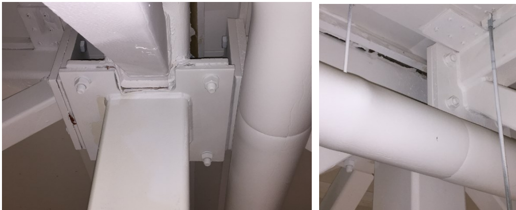
Kuva 65. Keskialueen pilarin liitos primääri- ja sekundääriristikkoon.
