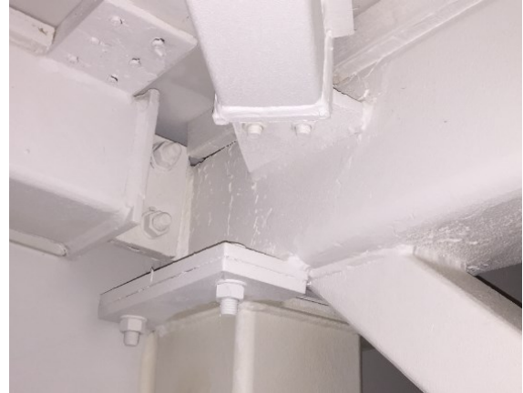
Kuva 68. Primääriristikko on kiinnitetty päätykehän pilariin suunnitelmien mukaisesti.
