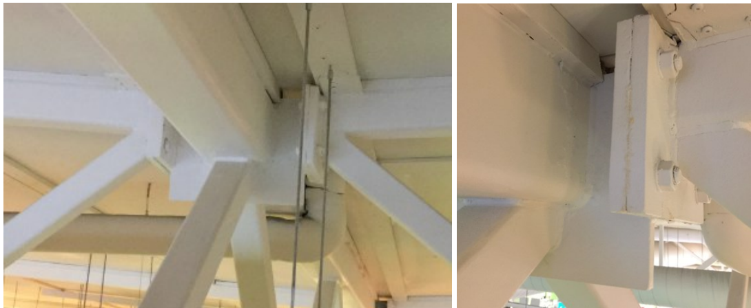
Kuva 67. Sekundääriristikon liitos primääriristikoon.
