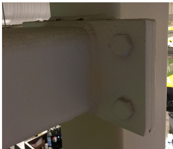
Kuva 66. Primääriristikon alapaarteiden liitos pilariin.
