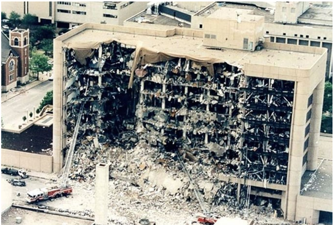
Kuva 34. Murrah Federal Office Building kärsi osittaisen sortuman. [14]
