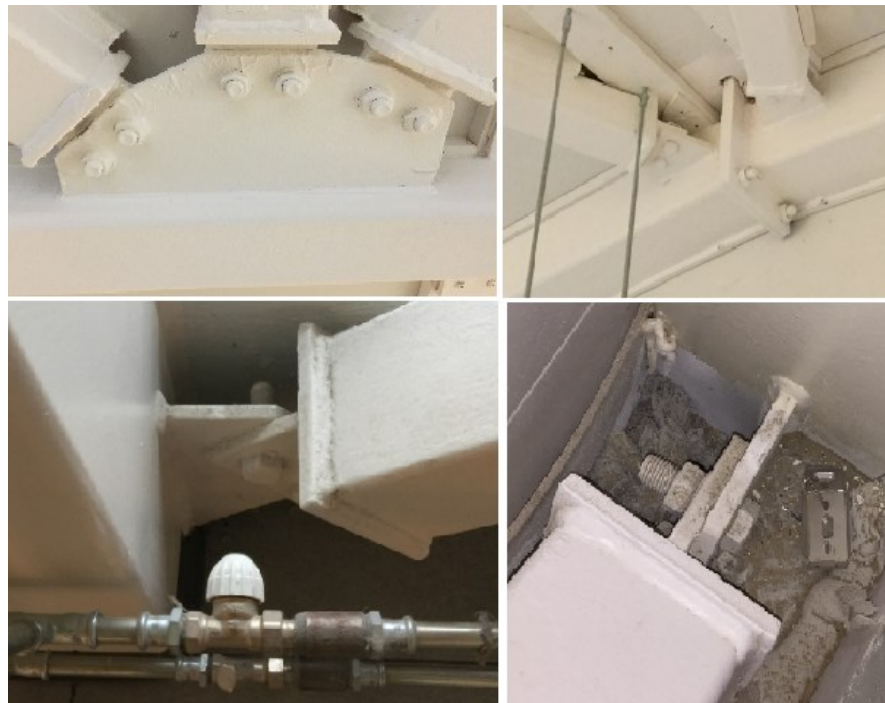
Kuva 71. Seinälinjan ja vesikattotason vinosauvojen liitoksissa ei havaittu vaurioita.
