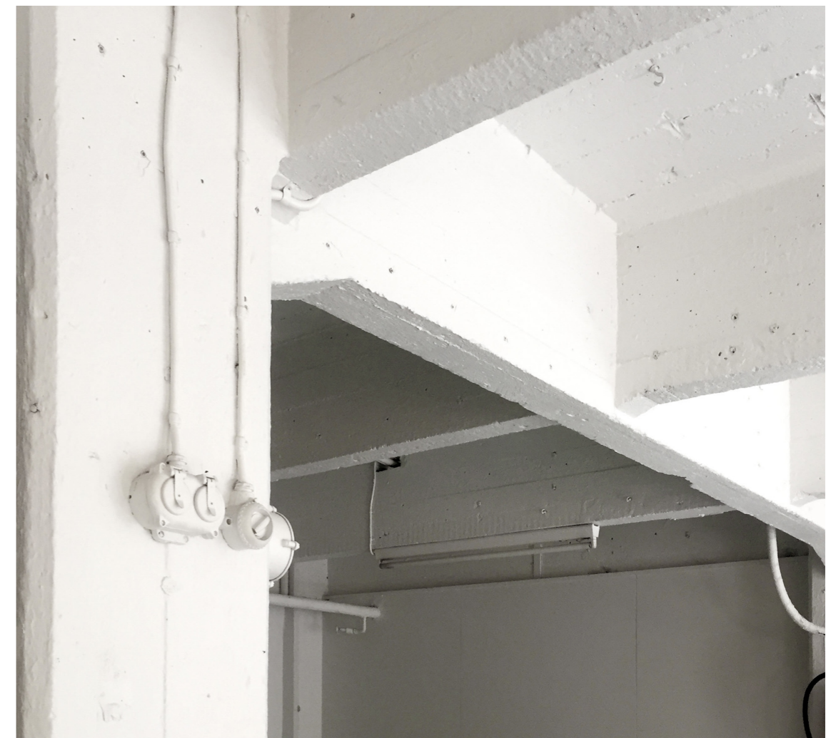
Kuva 15. Pilari-laatta-rakennejärjestelmä (Betoniteollisuus ry)
