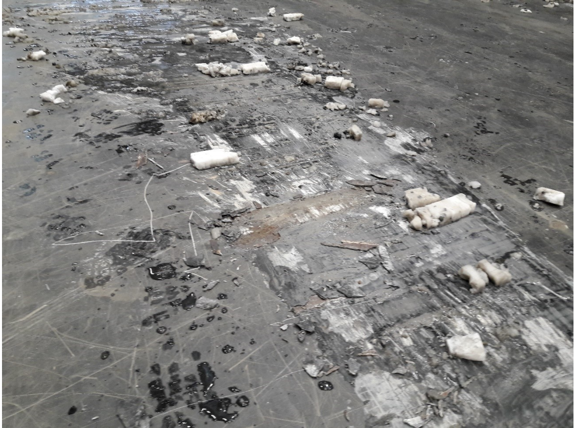
Kuva 9. Uuden tilan lattian kestävyyskokeilu
